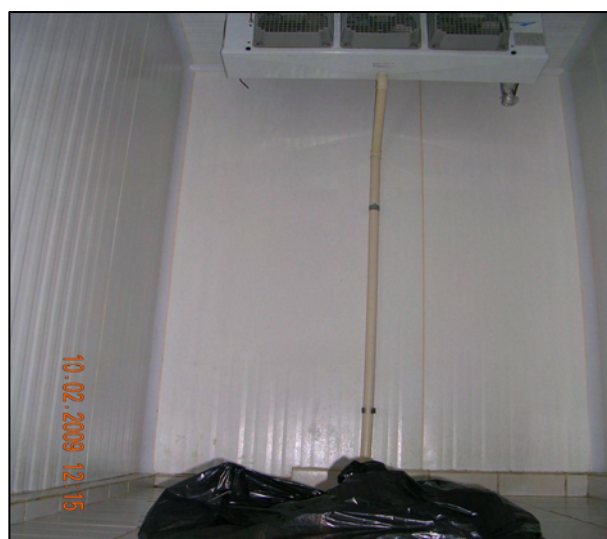
Foto 37 – Interior da câmara de resíduos. Fonte: Arquivo pessoal de Álvares, P.(2010) Data da foto: 10/02/2009.
