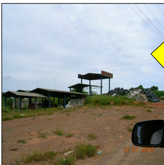
Foto 29 Fotografia 29 e 30 respectivamente – Usina de triagem desativada. Fonte: Arquivo pessoal de Álvares, P. (2010) Data da foto: 02/01/2010.
