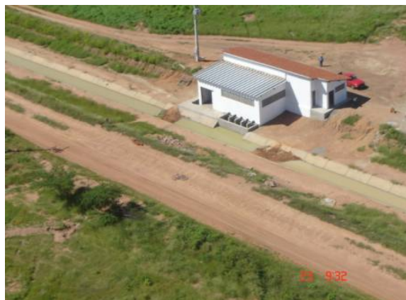
Figura 29. Perímetro de Irrigação Curupati – CE. Fonte: DNOCS (2009).
