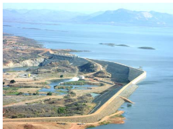
Figura 88. Vista aérea do barramento e da rodovia de ligação entre a BR 116 e Jaguaribara - CE. Fonte: DNOCS, 2009.
