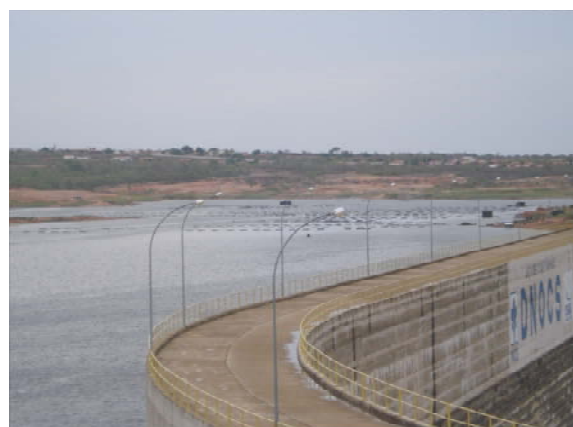
Figura 82. Localização da piscicultura do Castanhão. Note-se a ausência de cobertura vegetal. Fonte: DNOCS, 2009.
