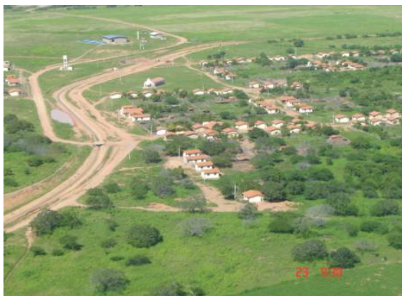
Figura 28. Perímetro de Irrigação Curupati – CE. Fonte: DNOCS (2009).
