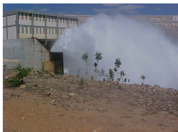
Figura 36. Casa de máquinas e válvula dispersora do Açude Castanhão – CE. Fonte: Acervo do autor.
