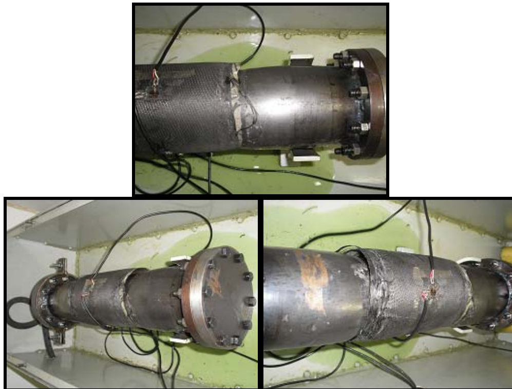
Figura 5.43: Situação do reparo após o rompimento do tubo.
