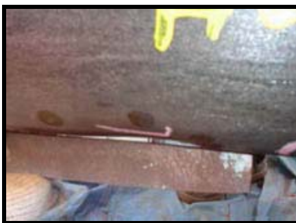
Figura 1.3: Profundidade da moessa.
