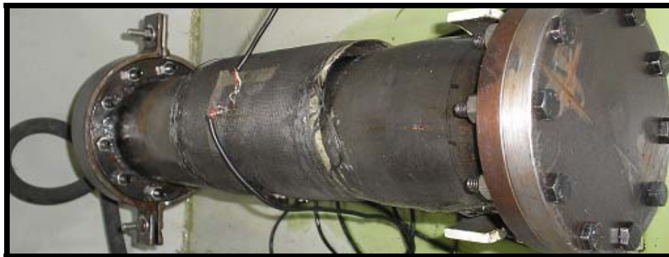
Figura 5.46: Descolamento do reparo em relação ao tubo após a ruptura do mesmo.
