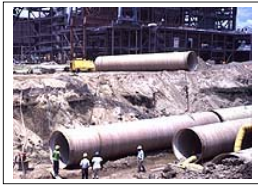
Figura 1.1: Reparo e manutenção de tubulações da Empresa Owens Corning (Owens Corning, 2006).
