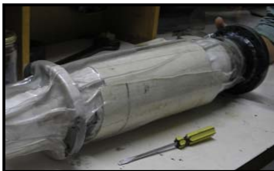
Figura 3.24: Colocação do P.V.C. ao redor do tubo.
