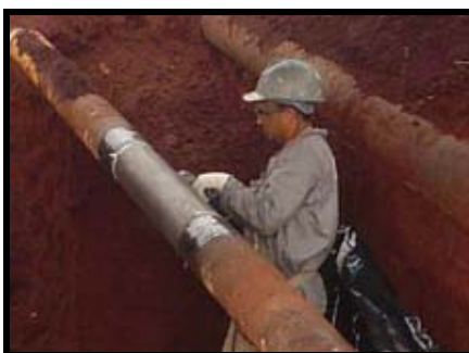
Figura 1.4: Preparação da superfície com escova de aço.
