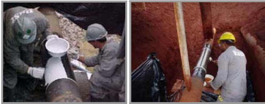
Figura 1.5: Impregnação manual de resina com auxílio de pincel.
