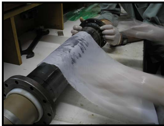
Figura 3.21: Colocação do filme de nylon ao redor do tubo.
