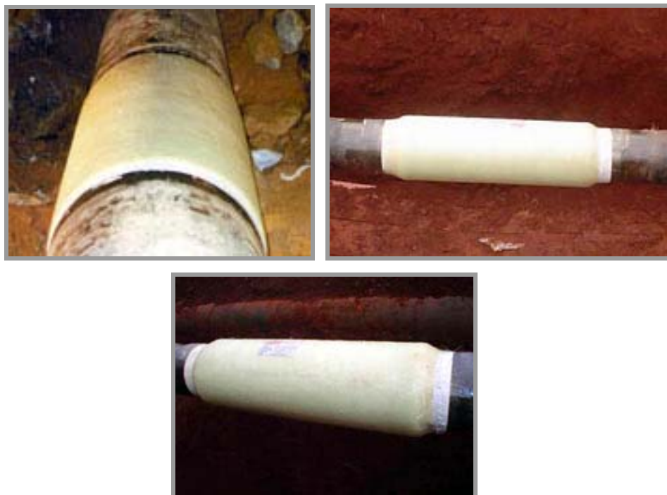
Figura 1.6: Reparo de vidro/epóxi na tubulação danificada.
