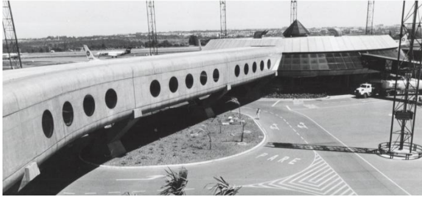
Figura 15: Vista externa da passarela de ligação entre o TPS e o Satélite Norte do SBBR.
