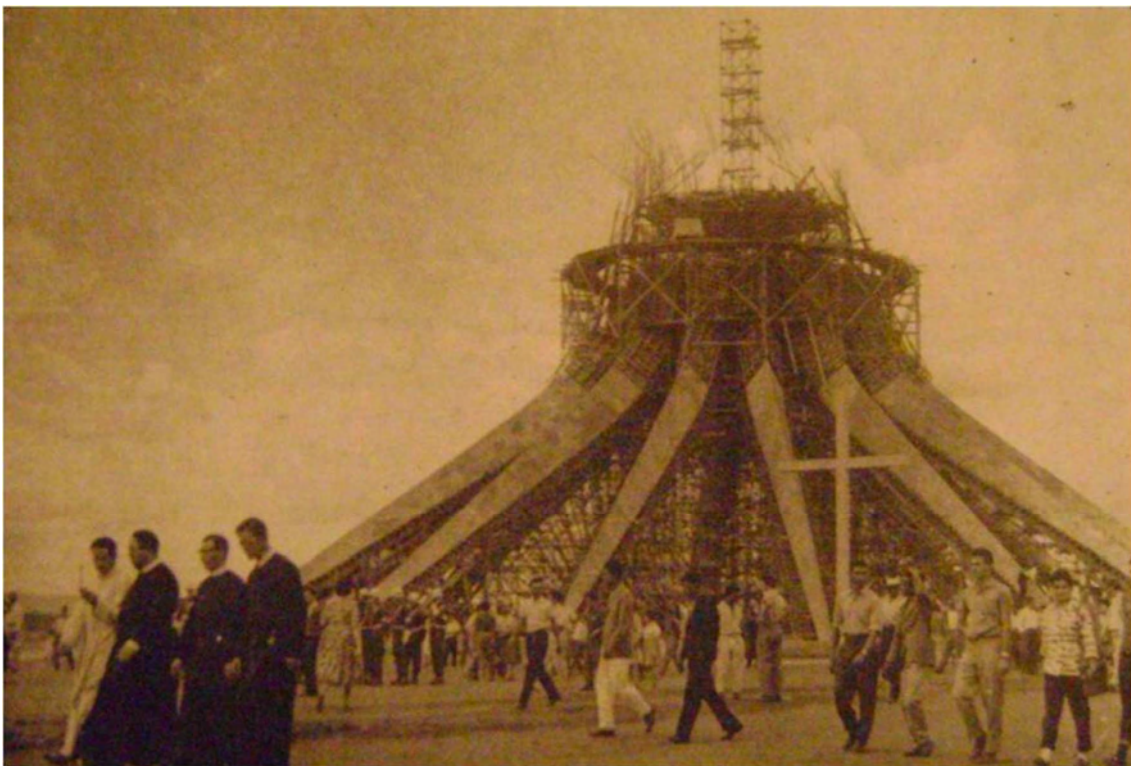
Figura 60 - Catedral em Construção.
