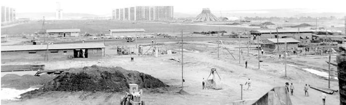
Figura 62 – Construção da Catedral.
