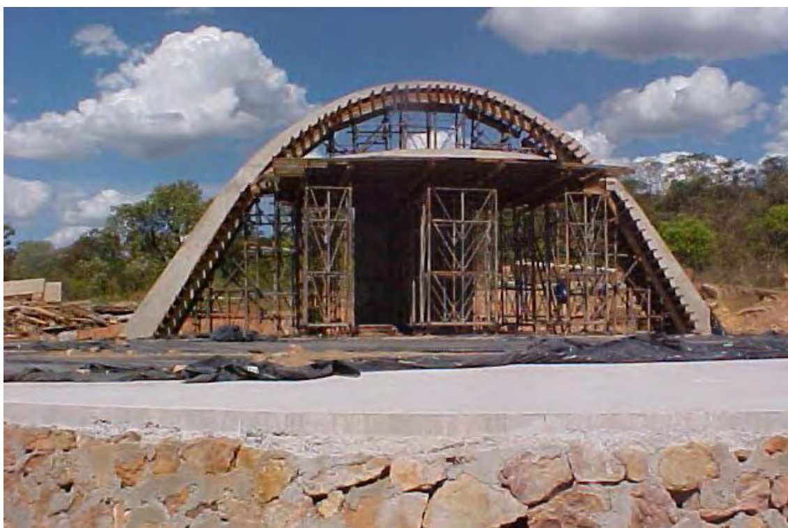
Figura 6 – Capela em Obras, 2005. Fonte: Acervo de Natanry Osório, 22 ago 2005.
