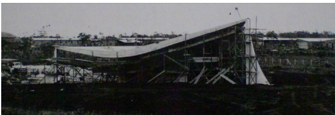
Figura 28 - Igreja Nossa Senhora de Fátima em construção. Fonte: Acervo DEPHA. Fotógrafo: Fontenelle. Data: 22 abr. 1958.
