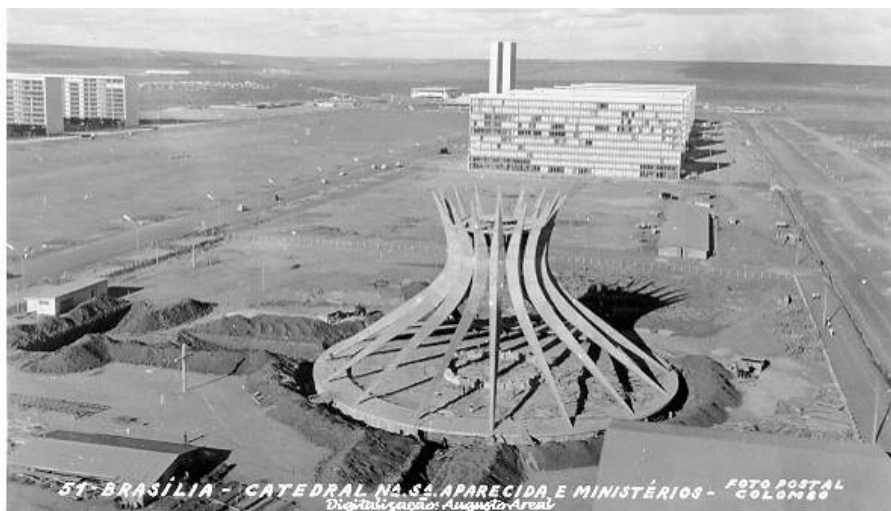
Figura 63 – Construção da Catedral.
