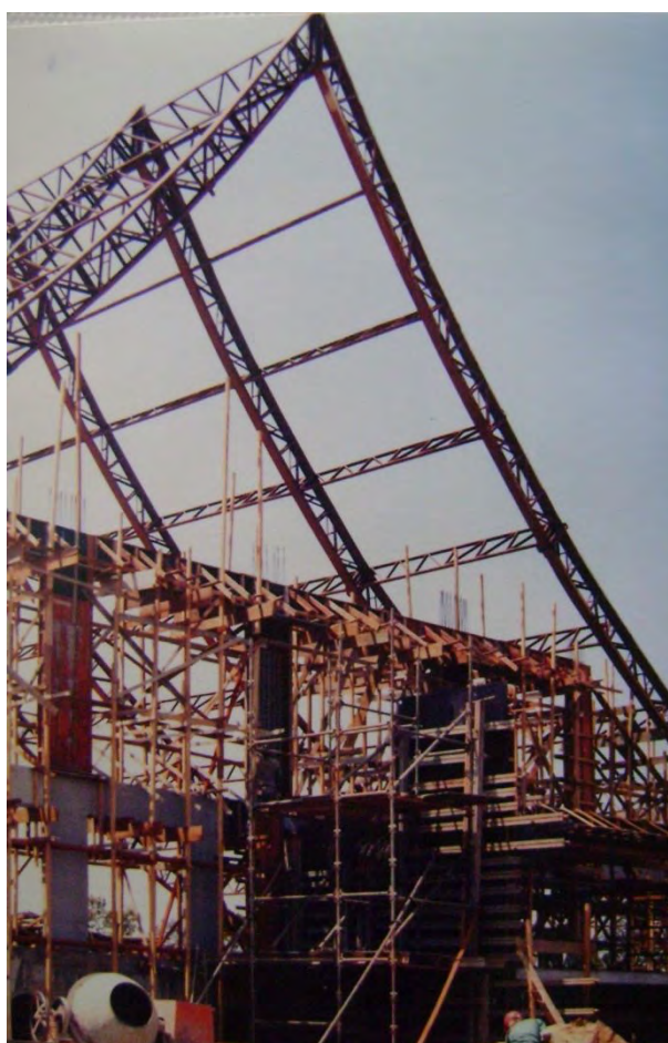
Figura 21 - Construção. Sem data. Fonte: Acervo da Catedral.
