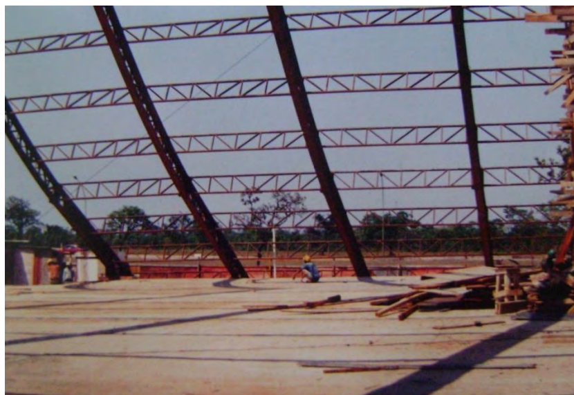
Figura 20 - Construção. Sem data. Fonte: Acervo da Catedral.
