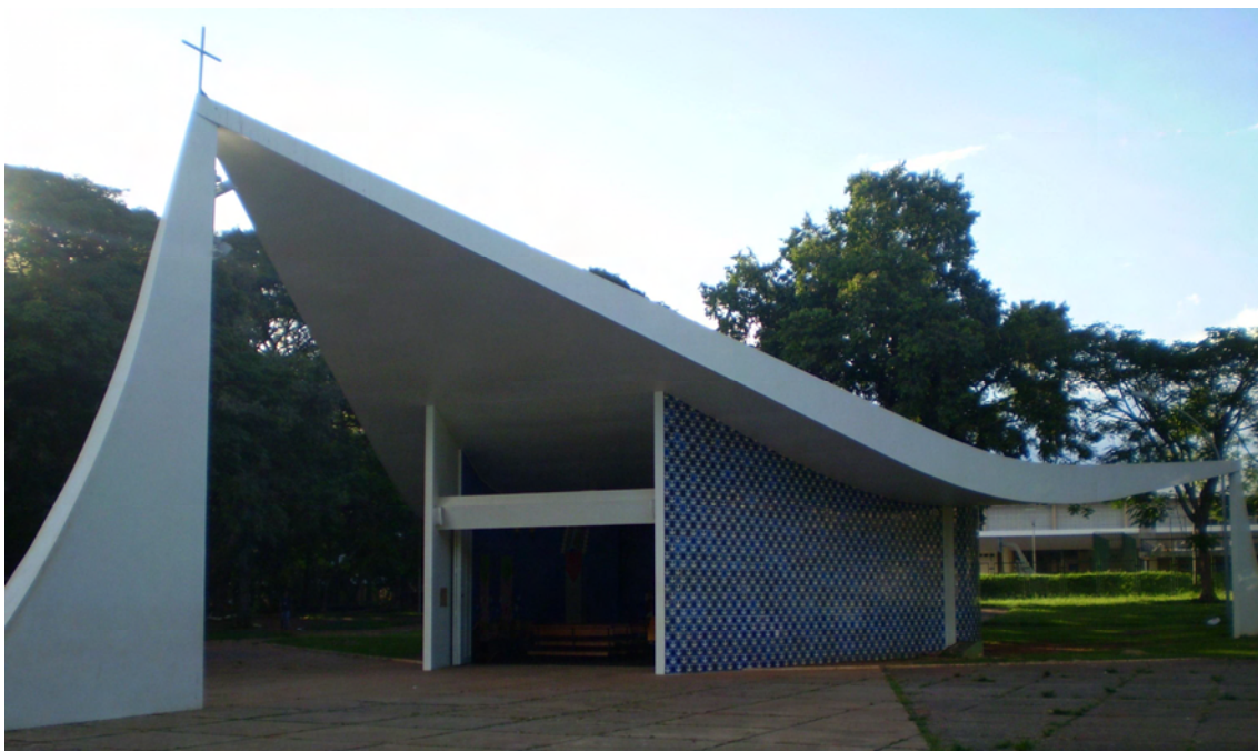
Figura 59 - Igreja Nossa Senhora de Fátima, 2010, após a restauração do IPHAN. Fonte: Foto da autora.
