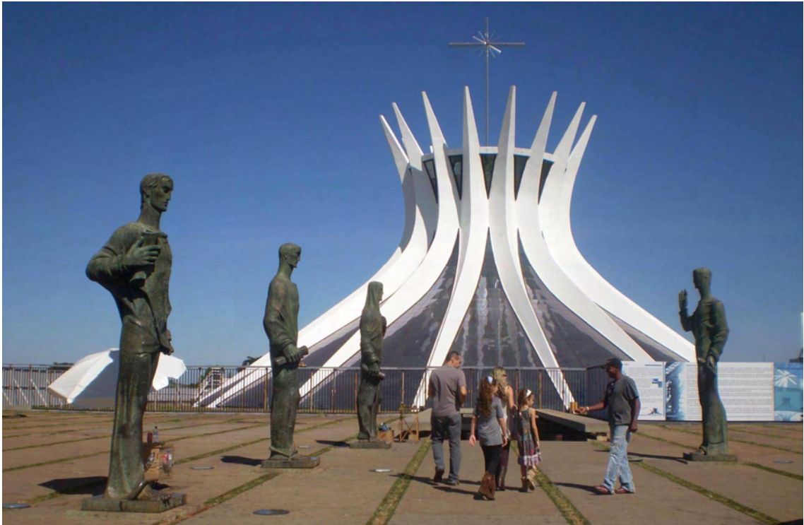
Figura 94 – Catedral ainda em reforma, já com metade dos vitrais colocados. Fonte: Foto da autora, 25 jun. 2010.
