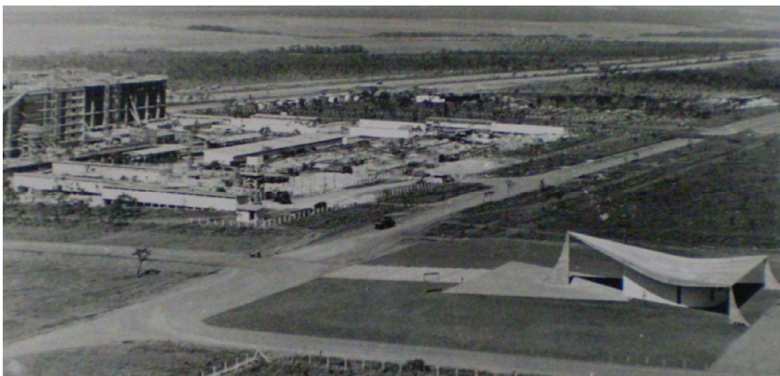
Figura 30 - Igreja Nossa Senhora de Fátima em construção. Fonte: Acervo DEPHA. Fotógrafo: Fontenelle. Ago. 1958.
