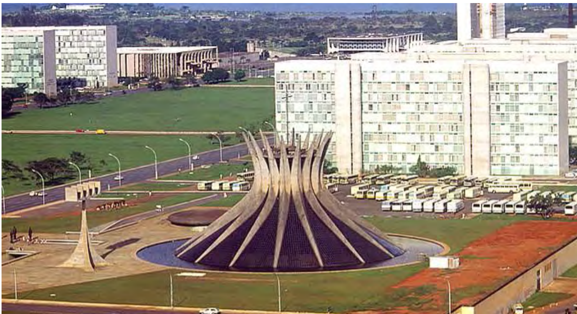
Figura 74 – Catedral antes da reforma.
