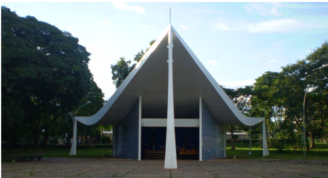
Figura 60 - Igreja Nossa Senhora de Fátima, 2010, após a restauração do IPHAN. Fonte: foto da autora.
