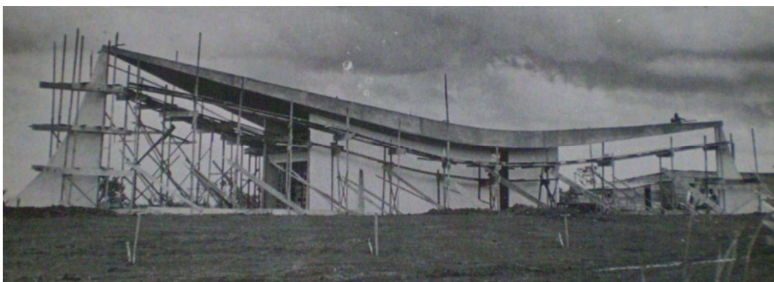
Figura 29 - Igreja Nossa Senhora de Fátima em construção. Fonte: Brasília nº 17, mai. 1958. p. 07.
