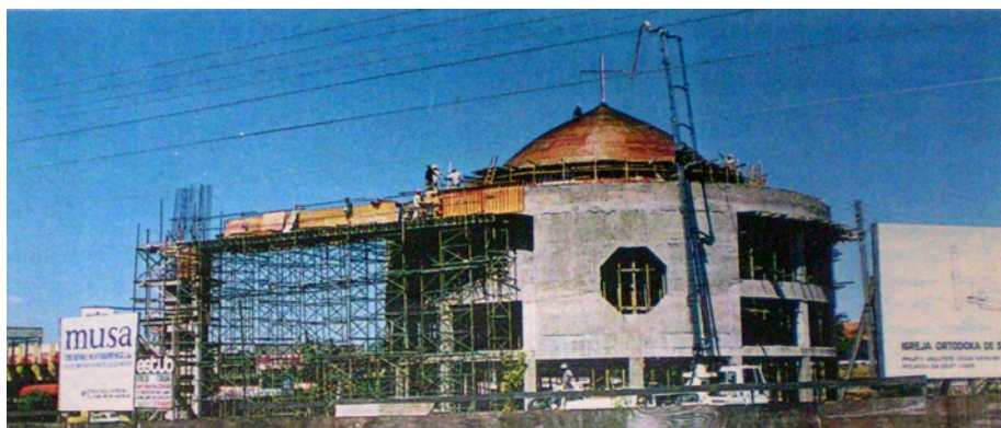
Figura 21 - Construção da Igreja Ortodoxa, 1994. Fonte: Fundação Oscar Niemeyer.
