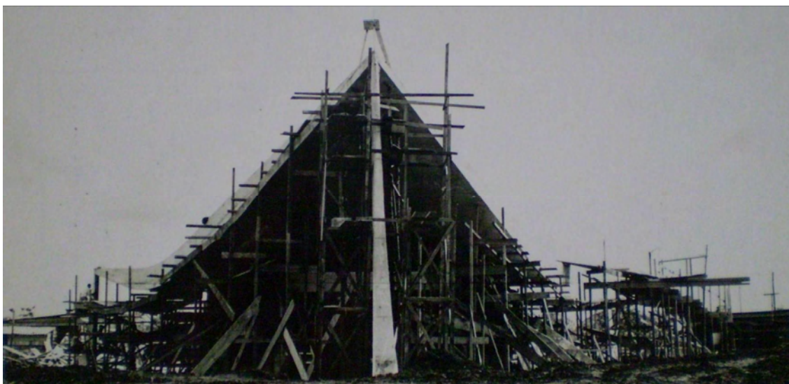
Figura 27 - Igreja Nossa Senhora de Fátima em construção. Fonte: Acervo DEPHA. Fotógrafo: Fontenelle. Data: 22 abr. 1958.
