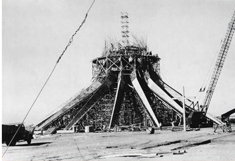
Figura 59 - Construção da Catedral.
