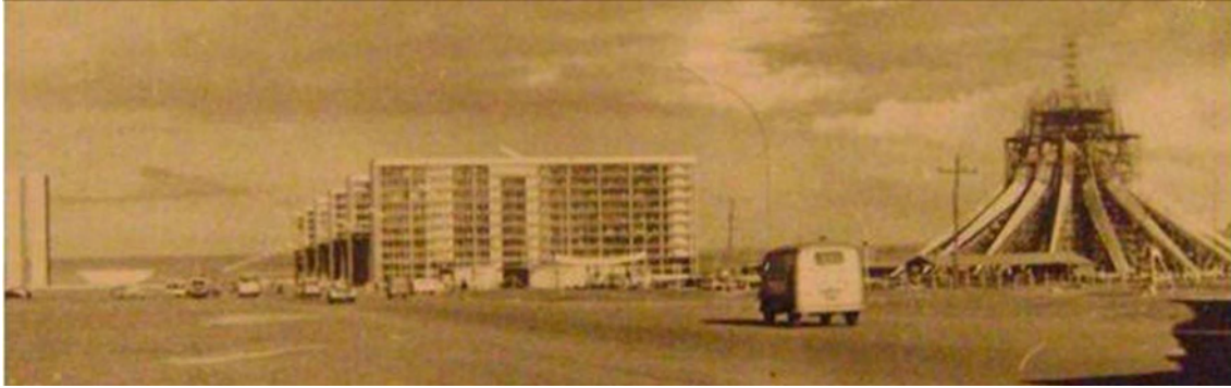
Figura 61 - Catedral em Construção.
