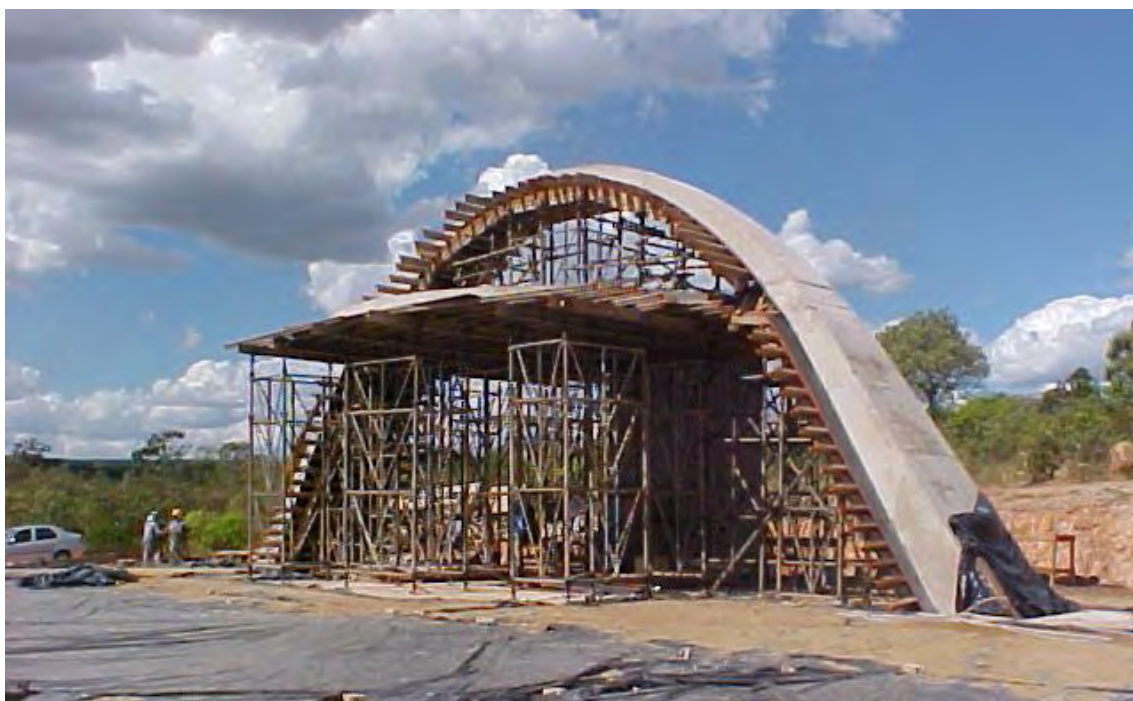
Figura 7 - Capela em Obras, 2005. Fonte: Acervo de Natanry Osório, 22 ago 2005.
