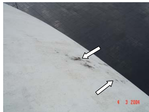
c) Trincas na superfície externa – Ponto 7 d) Trincas na superfície externa – Ponto 8.
