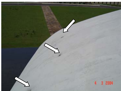
c) Trincas na superfície externa – Ponto 7 d) Trincas na superfície externa – Ponto 8.
