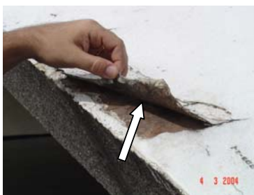
Figura 3.23 - Detalhe da camada de impermeabilização. A seta indica a pintura de neoprene (Fone: Relatório técnico nº10/2004 da CRO-11).
