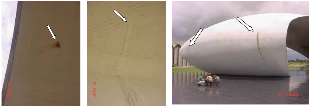
a) Afloramento na superfície interna – Ponto 1. b) Afloramento na superfície interna – Ponto 2. c) Afloramento na superfície externa – Ponto 3.
