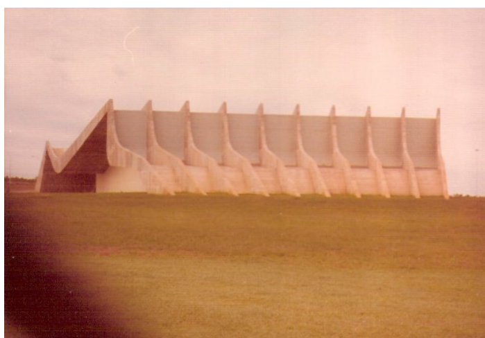
Figura 4.4 - Teatro Pedro Calmon em fase de acabamento – vista da fachada norte (Arquivos CRO-11 – Pasta da Obra N°525).
