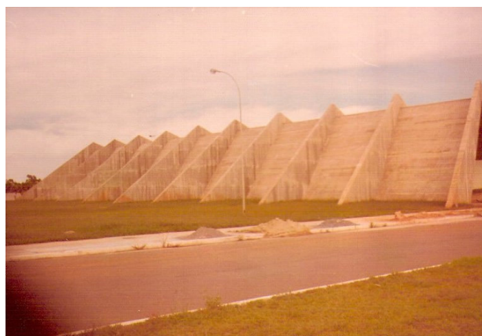
Figura 4.3 - Teatro Pedro Calmon em fase de acabamento – vista da fachada sul (Fonte: Arquivos CRO-11 – Pasta da Obra N°525).
