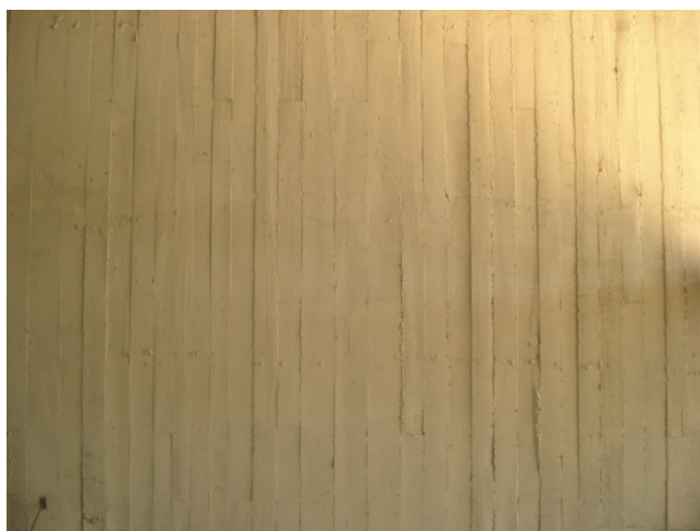
Figura 4.8 - Formato dado pelas fôrmas de madeira (Fonte: Autor).
