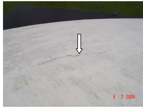
a) Trinca na superfície externa – Ponto 5. b) Trinca na superfície externa – Ponto 6.
