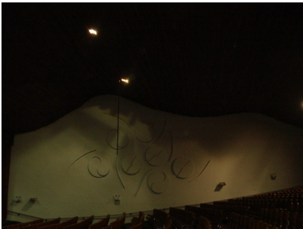
Figura 4.7 - Painéis de concreto do Teatro Pedro Calmon (Fonte: Autor).
