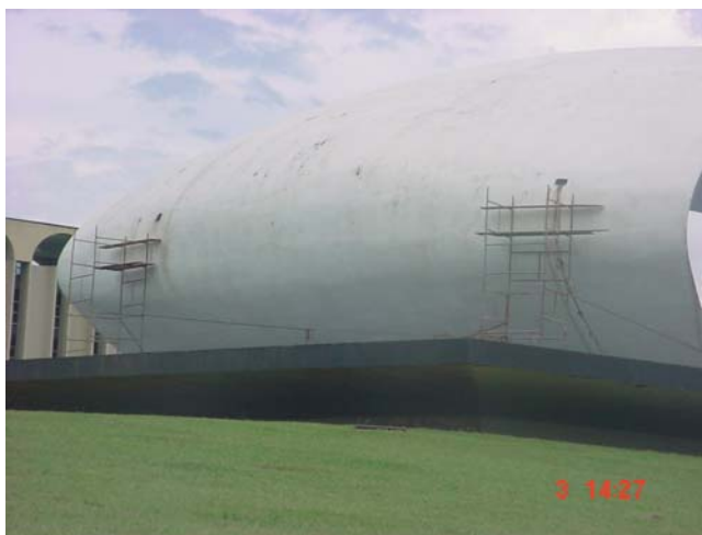
Figura 3.17 - Cortes executados na superfície externa do monumento (Fonte: Relatório técnico n°10/2004 da CRO-11).
