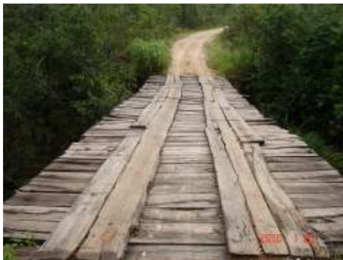
Figura 41 - Ponte no caminho de acesso ao reservatório da UHESM no município de Colinas do Sul – GO. Fonte: Foto do autor.
