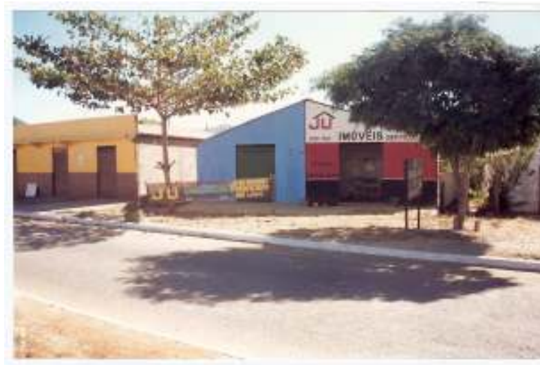
Figura 34 - Instalações de imobiliárias destinadas à venda de terrenos às margens do reservatório da UHESM no município de Colinas do Sul – GO. Fonte: Foto do autor.
