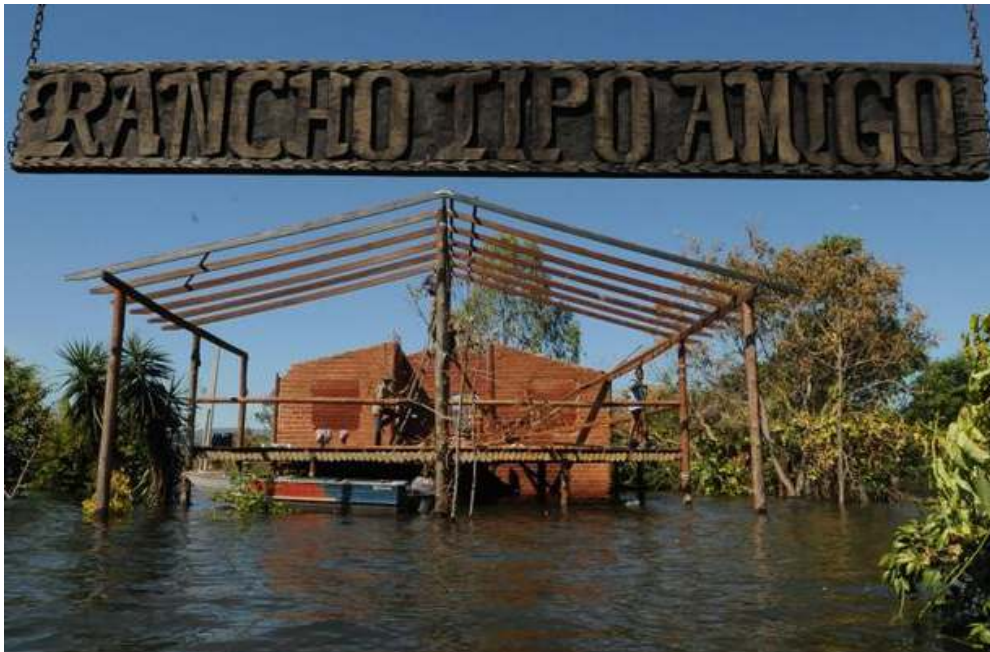
Figura 37 - Construção inundada no município de Niquelândia – GO. Fonte: Foto de Edilson Rodrigues – Correio Braziliense/DA Press.
