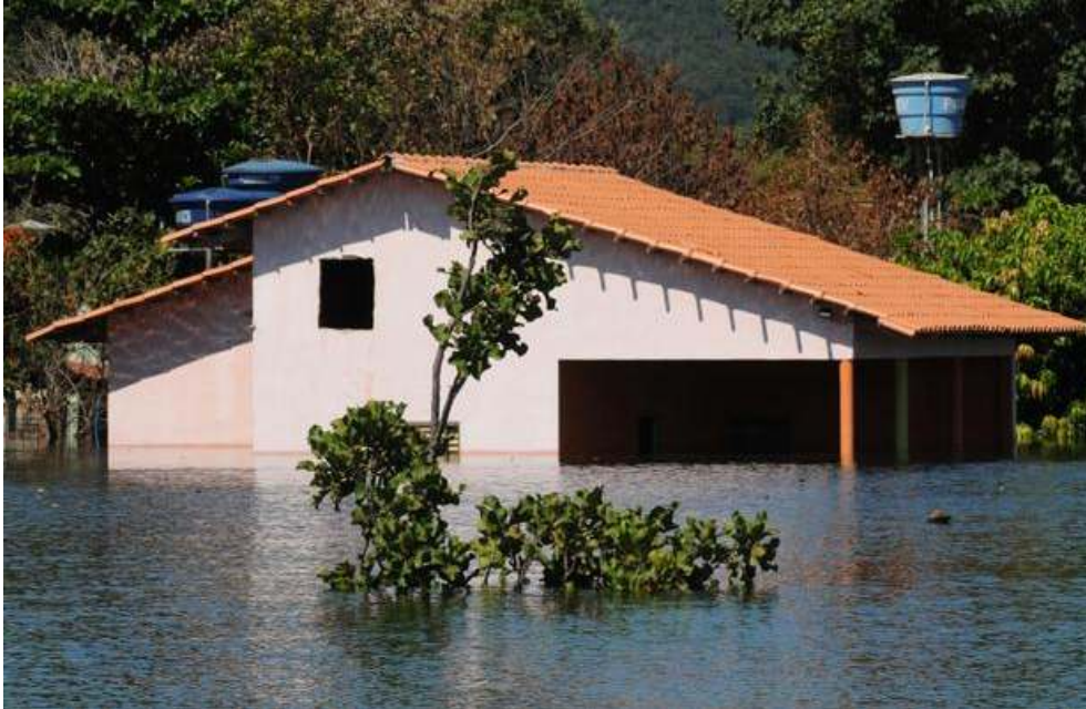
Figura 36 - Construção irregular em área de inundação do reservatório da UHESM, no município de Niquelândia – GO. Fonte: Foto de Edilson Rodrigues – Correio Braziliense/DA Press.
