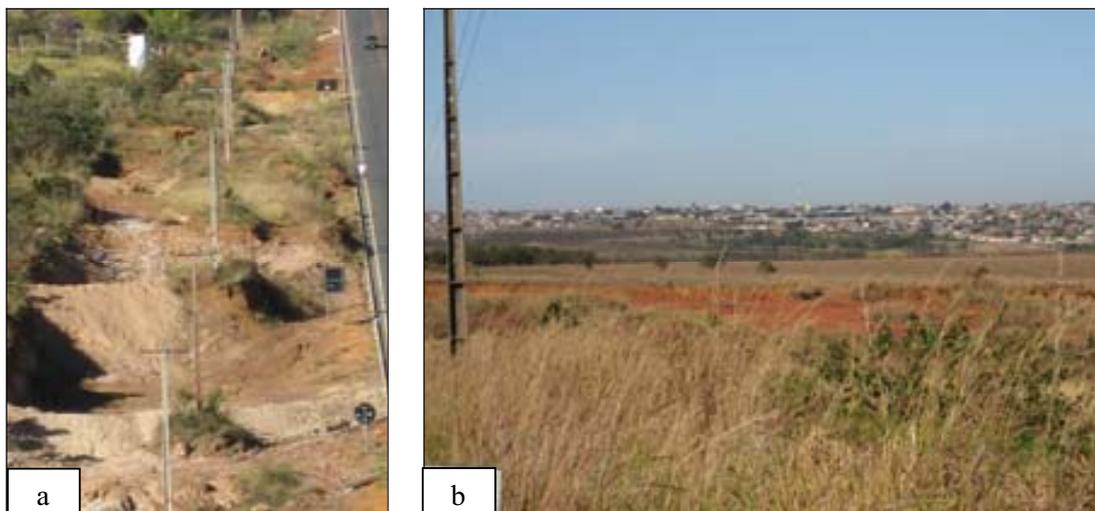
**Figura 2.17** - Extração de material ao longo de uma estrada no Alto do Descoberto. (a) Caixas de empréstimo. (b) Cascalheiras. Fotos: Elenjuce Valentin em 20 de junho de 2007.
