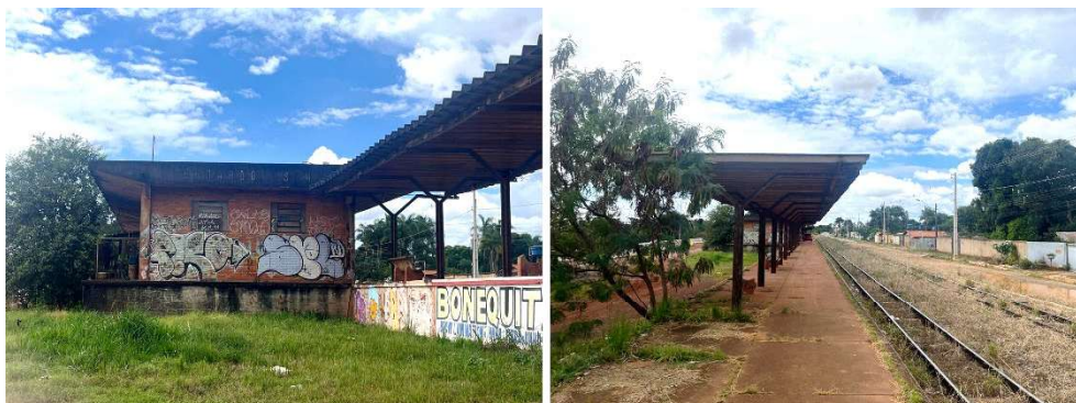
Figura 6. Registros do estado de conservação da Estação Bernardo Sayão, Brasília, Brasil. Marcela Chagas, 2025.
