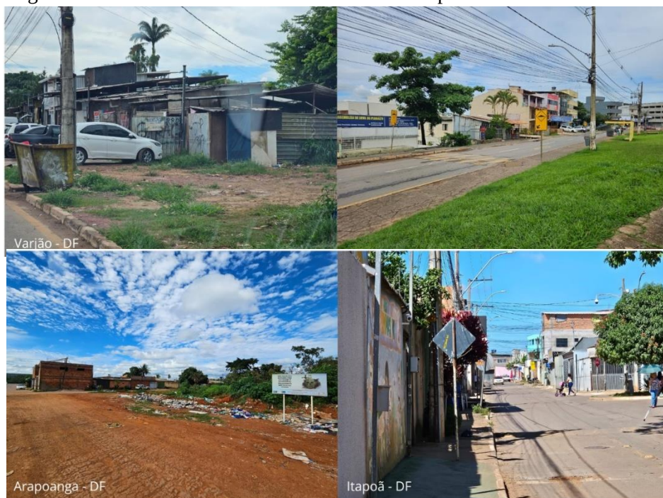
Figura 5: Fotografias das RAs do Distrito Federal com maiores problemáticas em infraestrutura urbana.
