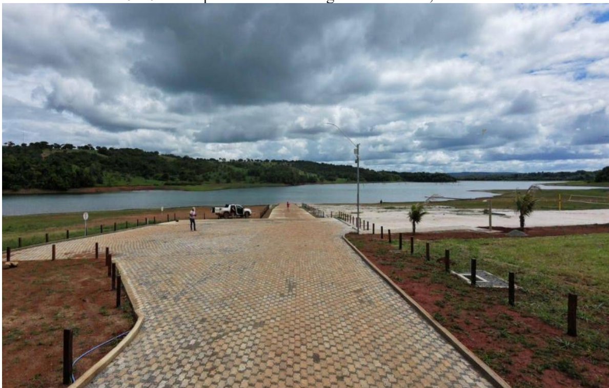
Anexo 9.10 – Rampa de acesso ao Lago Corumbá IV, Luziânia - GO.
