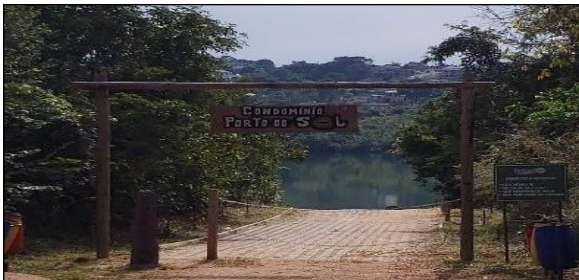
Figura 6 – Rampa de acesso construída em Área de Preservação Permanente (APP).
