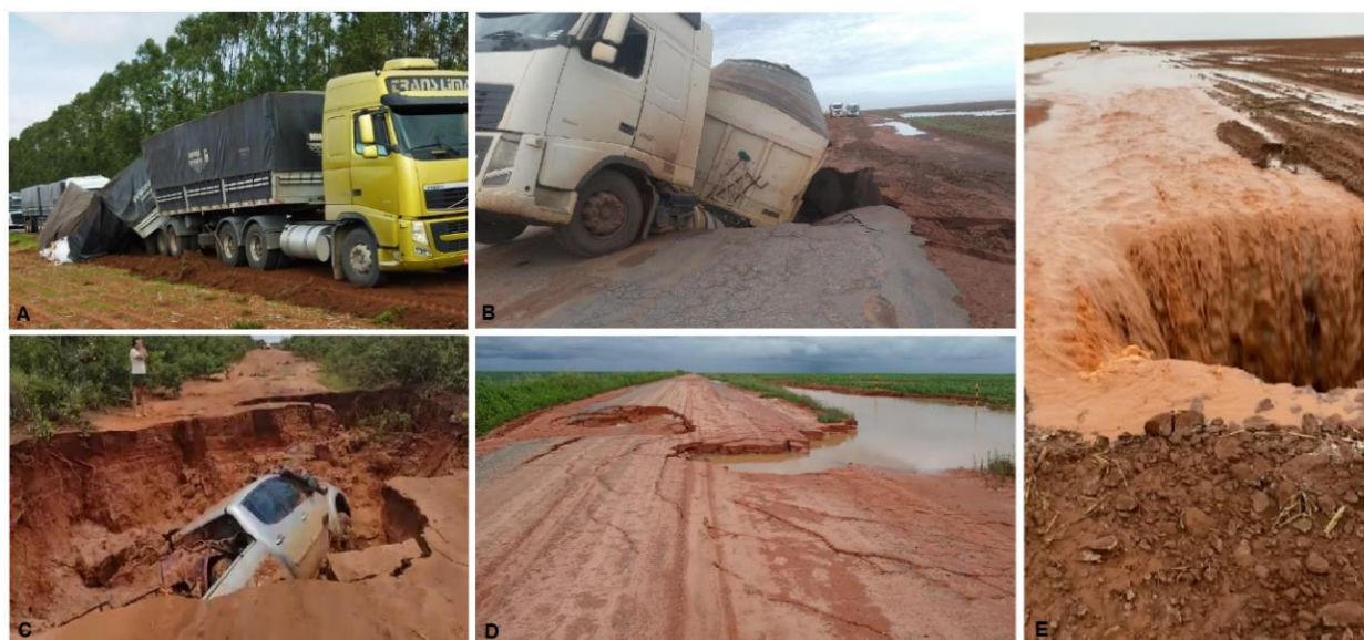
Figura 5.10. Associação de abatimentos com acidentes de caminhões (A e B), Caminhonete numa ravina “cega” (C), destruição de trecho da estrada pela interconexão de abatimentos (D) e a cachoeira de enxurrada em sumidouro (pipe inlet) (E), ocorridos em novembro de 2021 e janeiro de 2022 na região do Coaceral (imagens cedidas por: David Schmidt).
