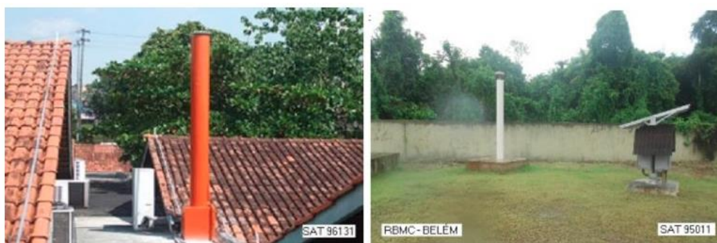
Figura 02: Exemplos de monumentações GNSS da RBMC. À esquerda: monumentação em pilar de concreto em laje de edifício. À direita: monumentação em pilar de concreto no solo.
