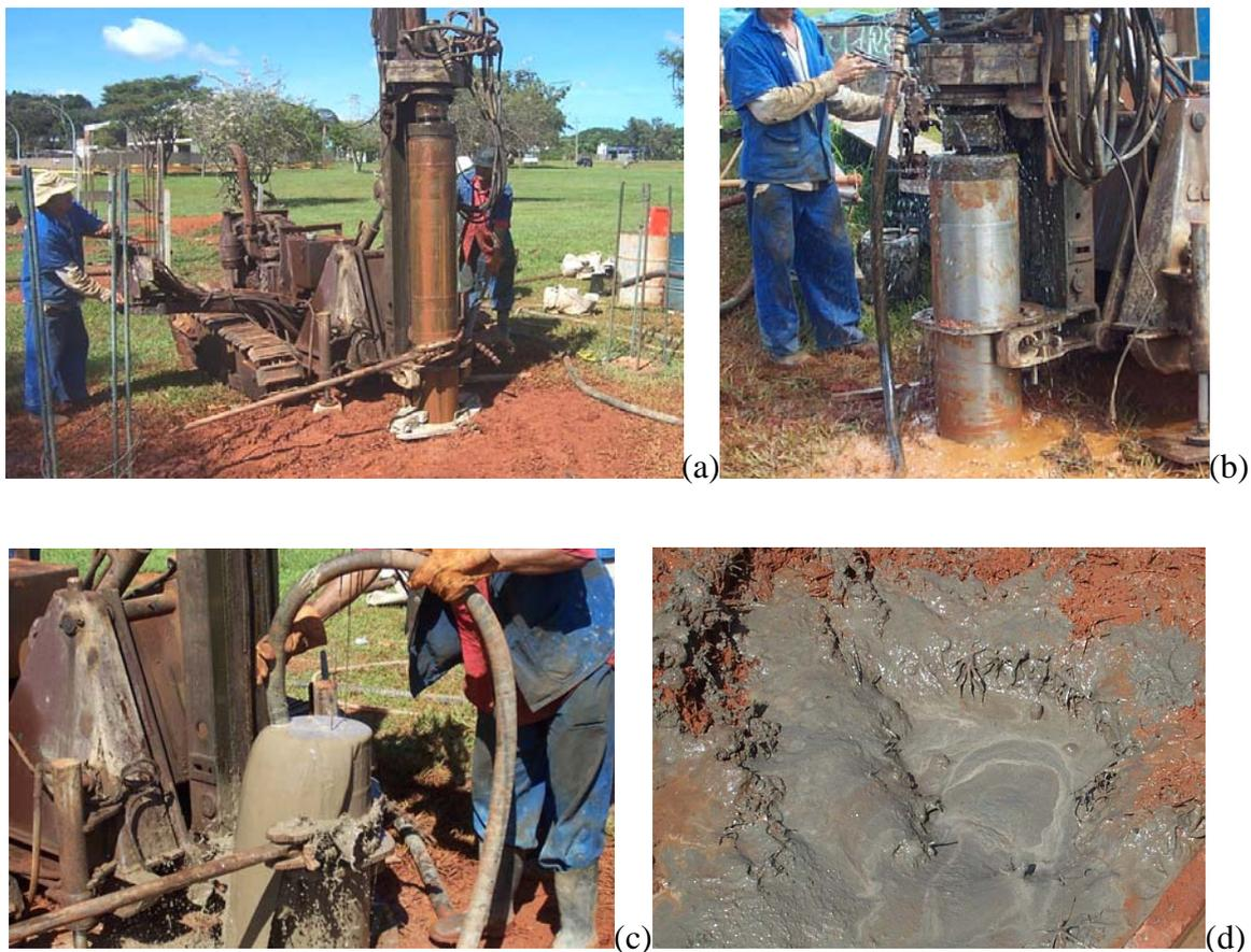
Figura 3.13 Execução das estacas escavadas no C.E.UnB
