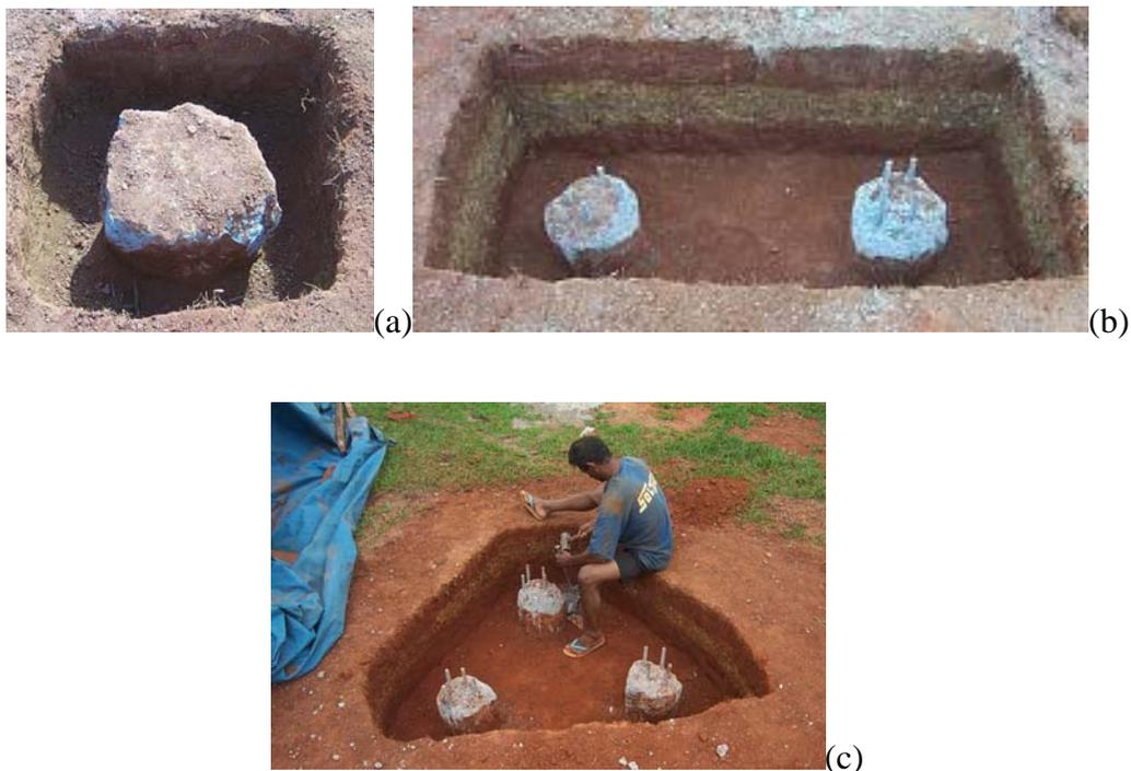
Figura 3.24 Estaca hélice contínua isolada (a) e em grupos (b, c)
