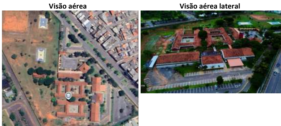
Quadro 29: Visão aérea da Escola Técnica de Brasília
