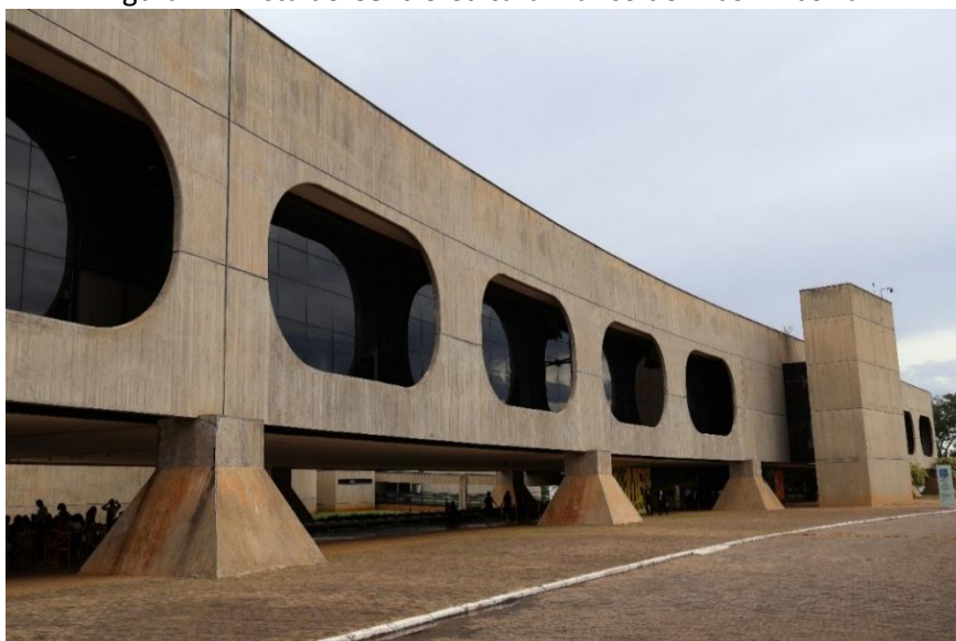
Figura 7 – Vista do Centro Cultural Banco do Brasil Brasília.
