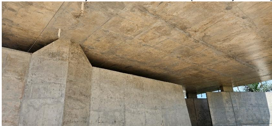
Figura 22 – Vista do fundo da laje da cobertura norte da BCE após os serviços de recuperação.
