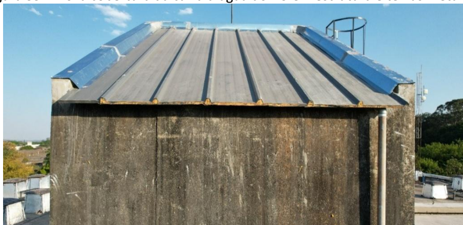
Figura 39 – Nova cobertura da caixa d'água do RU em estrutura e telhas metálicas.
