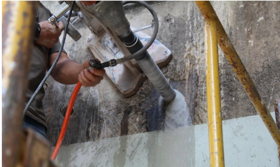
Figura 46 – Retirada de testemunhos do RU/UnB com uso de sonda rotativa do tipo serra copo.
