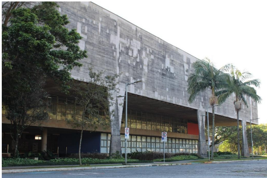
Figura 9 – Vista da fachada do prédio da Faculdade de Arquitetura e Urbanismo e de Design da Universidade de São Paulo – FAU-USP.
