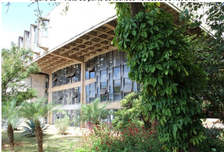
Figura 25 – Vista de parte da fachada nordeste do RU/UnB.
