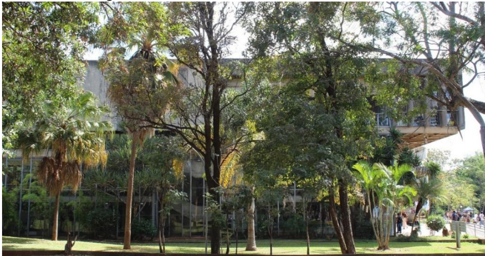
Figura 24 – Vista da fachada sudeste do RU/UnB.
