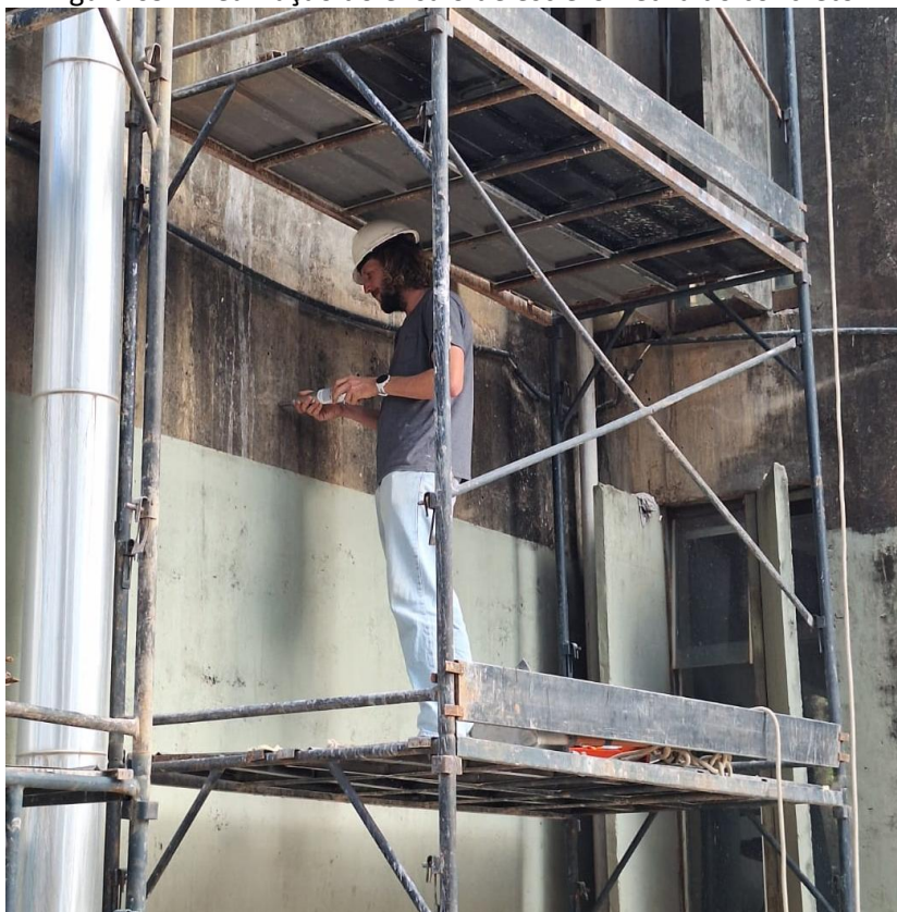
Figura 69 – Realização do ensaio de esclerometria do concreto.
