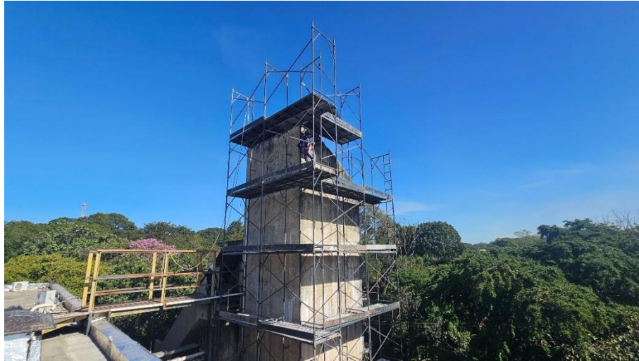
Figura 37 – Andaimas ao redor da caixa d'água do RU para processo de demolição e recomposição.
