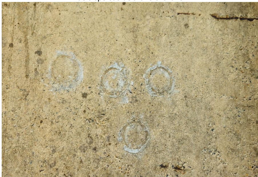
Figura 78 – Área 02 de ensaio de absorção de água com tubos Karsten 10 minutos após a aplicação de dispersão de silano-siloxano.
