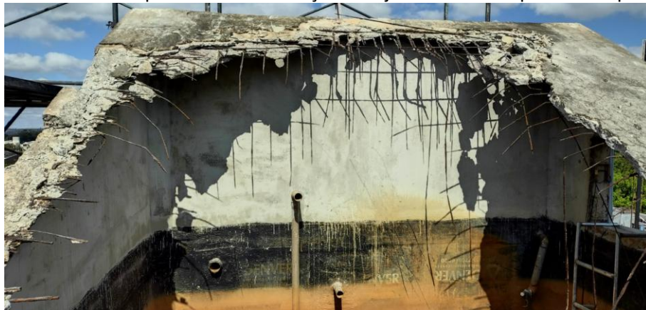
Figura 38 – Início do processo de demolição da laje de cobertura para recomposição.
