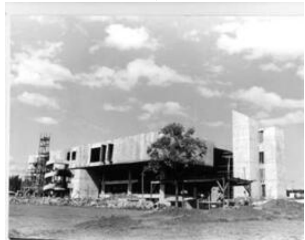
Figura 28 – Vista panorâmica lateral da construção do RU/UnB.
