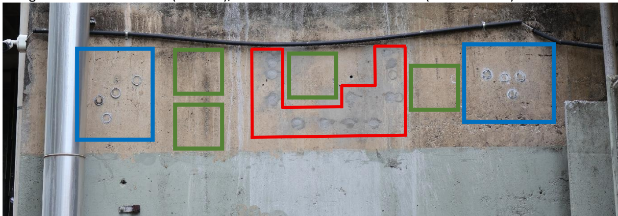
Figura 44 – Mapeamento dos locais de realização dos ensaios de esclerometria (em verde), absorção de água com tubos Karsten (em azul), e de retirada dos testemunhos (em vermelho).
