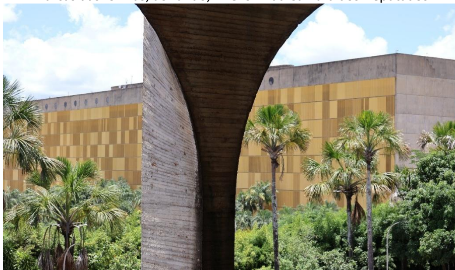
Figura 4 – Pilar em concreto aparente do Palácio do Itamaraty, em Brasília, com sua forma curva e marcas das formas; ao fundo, Anexo IV da Câmara dos Deputados.
