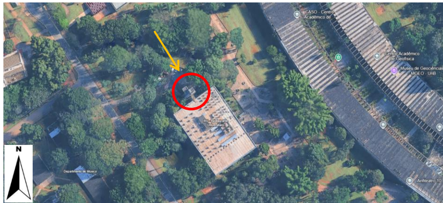
Figura 41 – Imagem de satélite do RU/UnB, com destaque para a torre do anexo com indicação da fachada em estudo.
