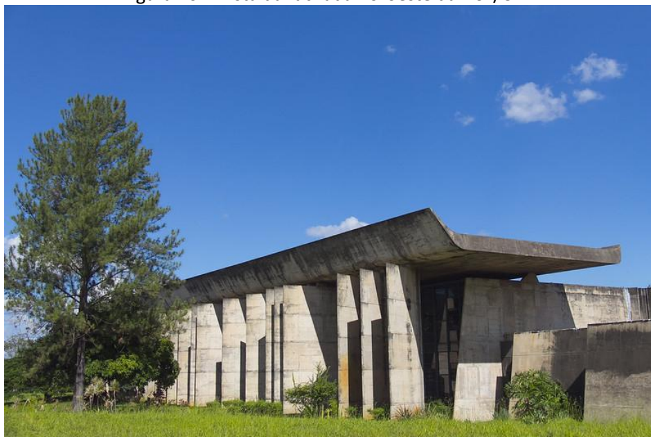
Figura 20 – Vista da fachada noroeste da BCE/UnB.
