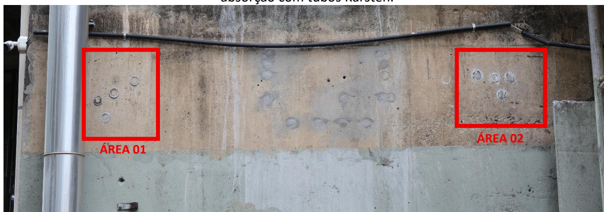
Figura 64 – Mapeamento dos locais de aplicação dos produtos protetores e realização do ensaio de absorção com tubos Karsten.
