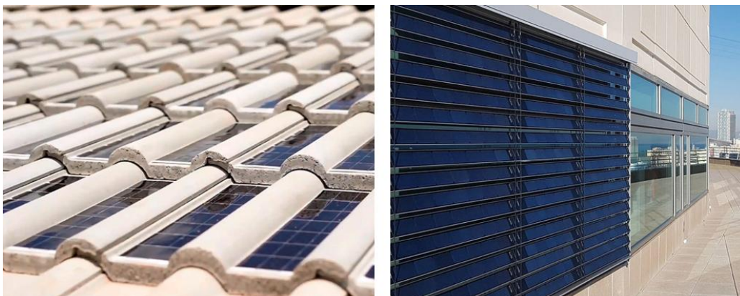
Figura 5: Telhas e persianas com sistemas fotovoltaicos integrados às edificações (BIPV).
