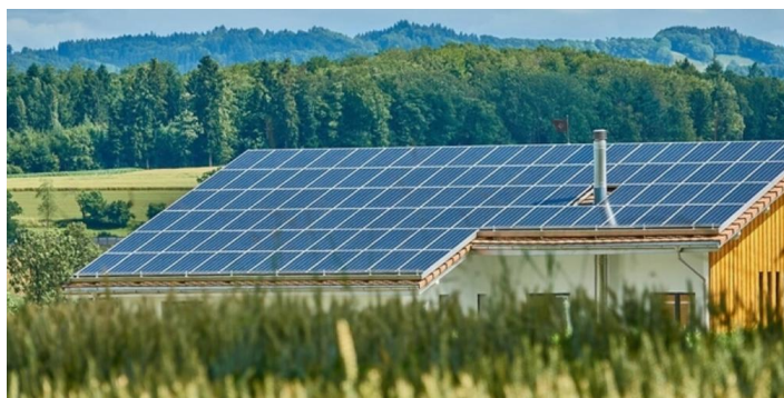
Figura 2: Sistemas fotovoltaicos integrados às edificações (BIPV) como telhado solar.
