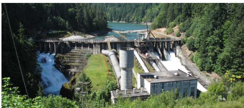
Figura 1.3 – Chaminé de equilíbrio em uma hidrelétrica. Fonte: Disponível em: < https://myedmondsnews.com/2016/04/edmonds-trout-unlimited-hosting-april-27-talk-on-elwha-river-restoration/ >. Acesso em: 24 de maio de 2024.
