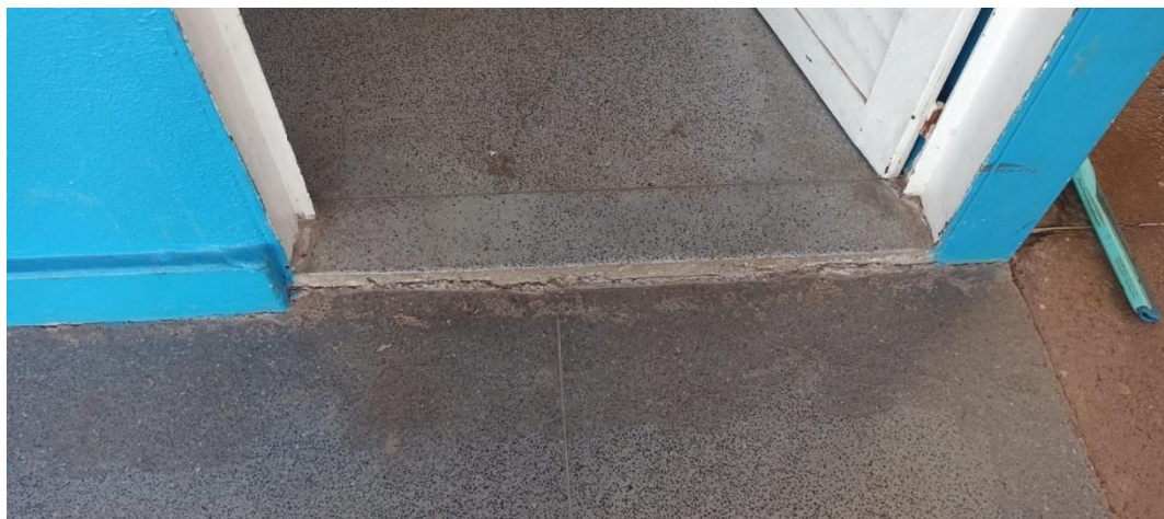
Figura 1 – Entrada sala de aula.
