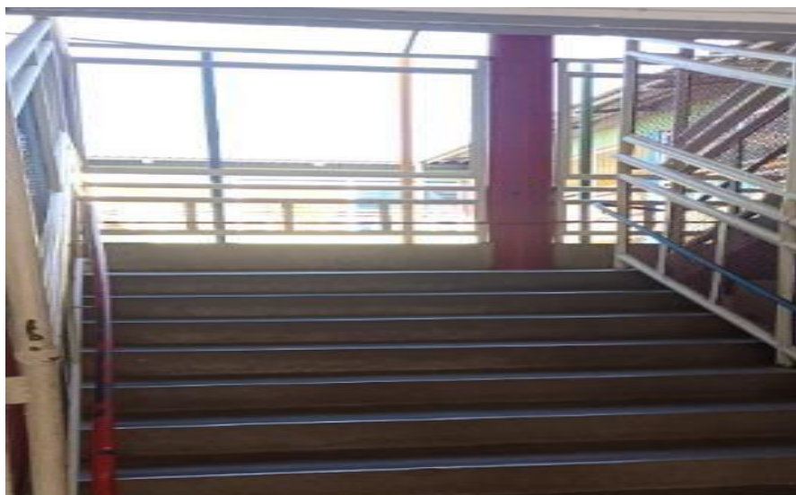
Figura 24 - Corrimão e guarda-corpo.
