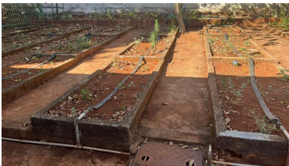
Figura 15 - Altura do pé direito reduzida nos ambientes
