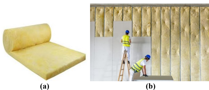
Figura 33 – Lã de vidro: (a) manta (ISOMIL, 2019) (b) aplicação em parede drywall (ISOVER, 2019).
