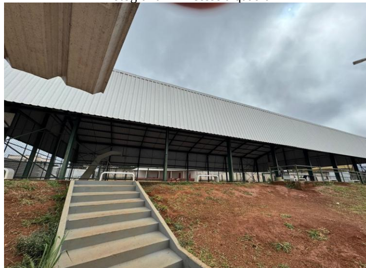
Fotografia 2 - Acesso à quadra
