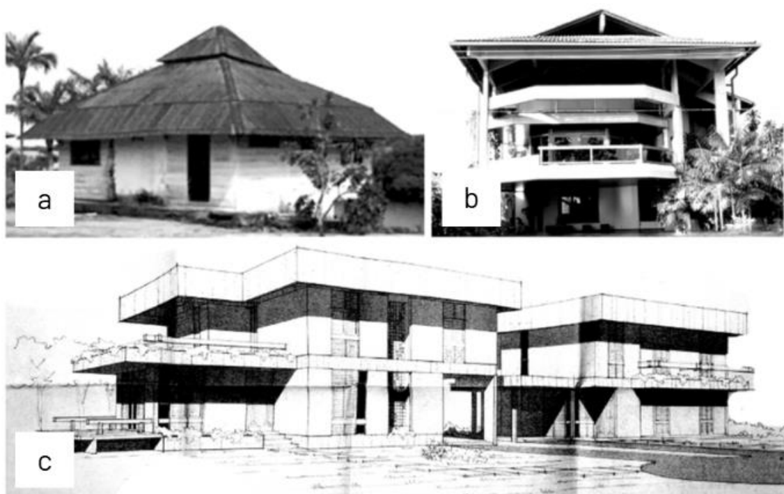
Figura 34 – Fachadas das residências: a) Praia da Lua; b) Orsine Oliveira; e c) Embaixada do Japão
