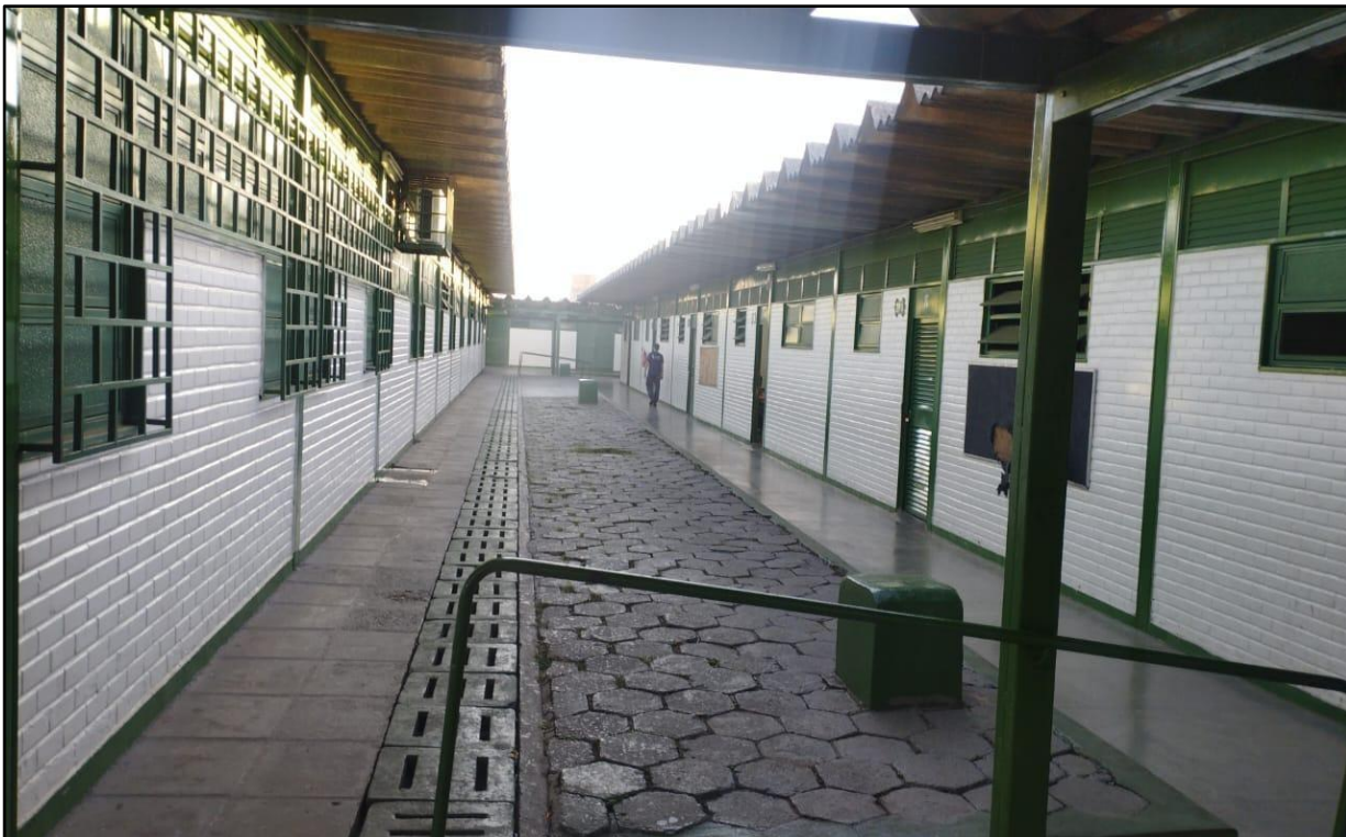
Figura 4 – Bloco IV do Centro de Ensino Fundamental 26 da Ceilândia (DF) Fonte: Elaborado pelo autor (2025).
