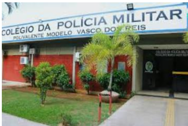
Figura 11 – Fachada do colégio CEPMG Vasco dos Reis
