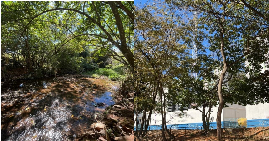
FIGURA 14 – Córrego Águas Claras e Estação de Tratamento
