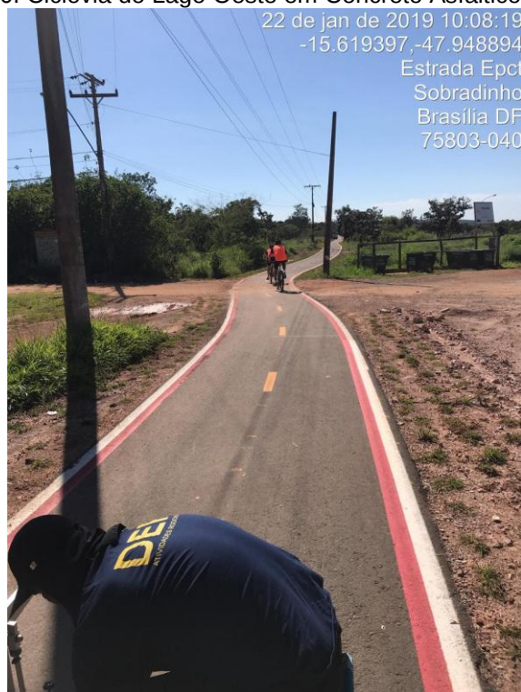
Figura 10. Ciclovia do Lago Oeste em Concreto Asfáltico (CAUQ).
