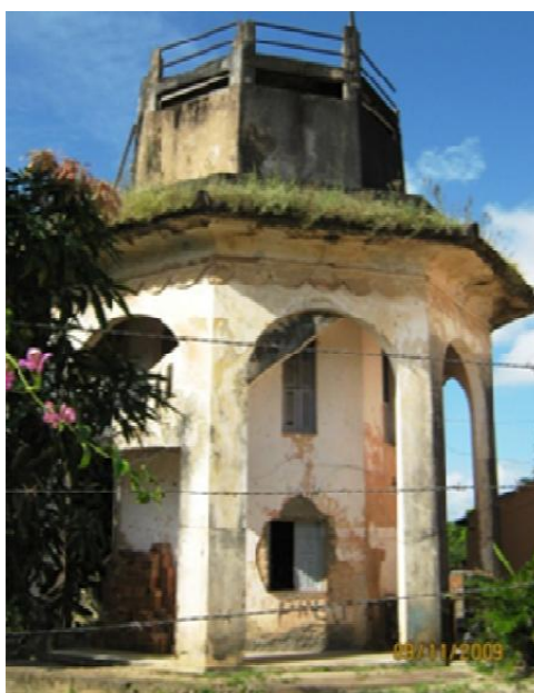
Figura 55: Casa da Caixa d'água, na Cidade de Menores 1022
