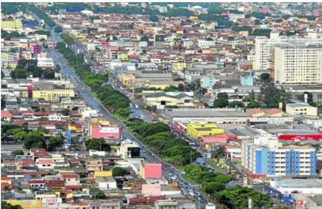
Figura 17 — Ceilândia, região administrativa do Distrito Federal
