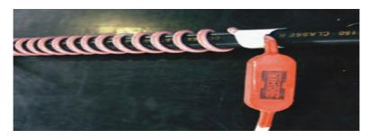
Figura 57 - Traço térmico enrolado na tubulação de alimentação de combustível.
