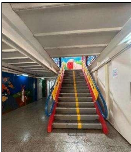
Figura 5. Escada interna interligando dois pavimentos da escola.
