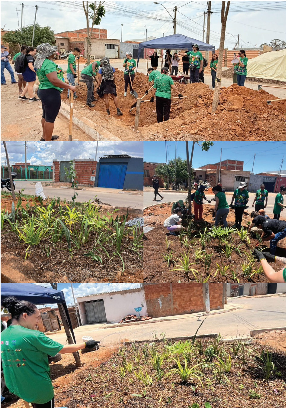
Figura 165: Registros da construção dos jardins de chuva da Quadra 209
