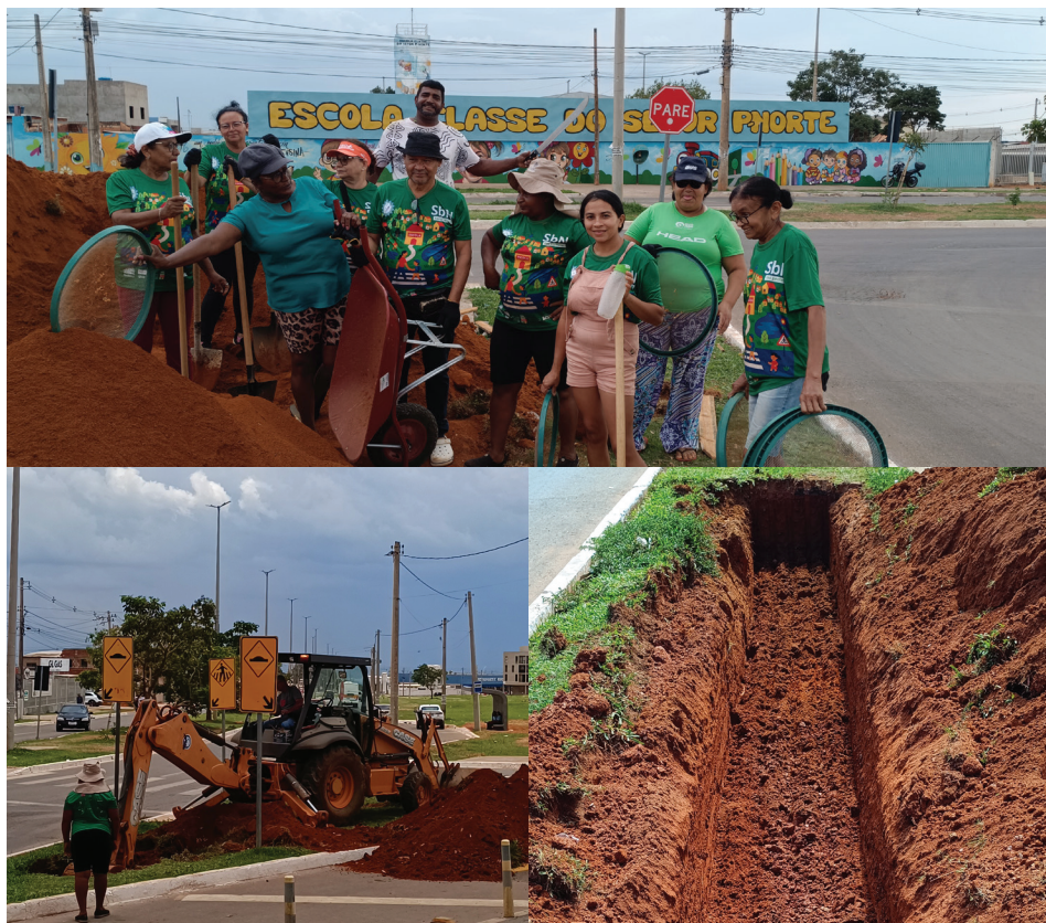
Figura 152: Acompanhamento comunitário de escavação dos berços para os jardins de chuva
