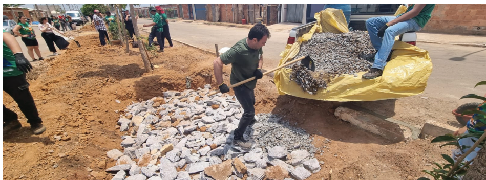
Figura 105: Etapa de colocação da camada drenante
