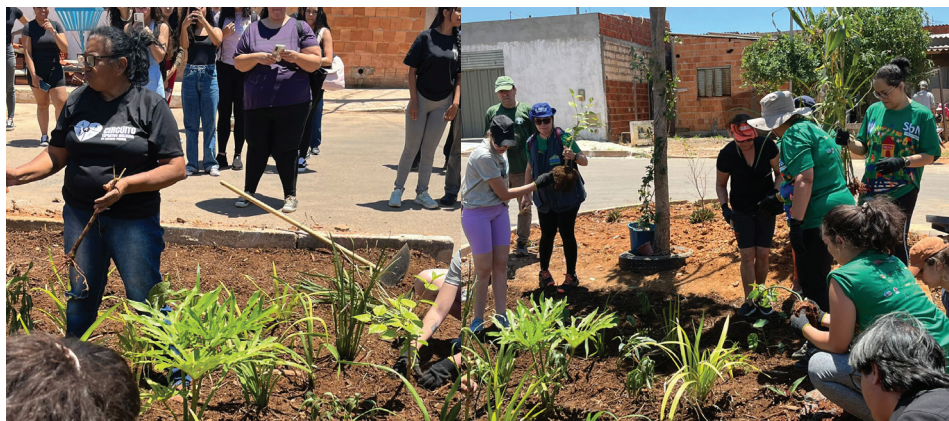
Figura 164: Construção dos jardins de chuva da Quadra 209
