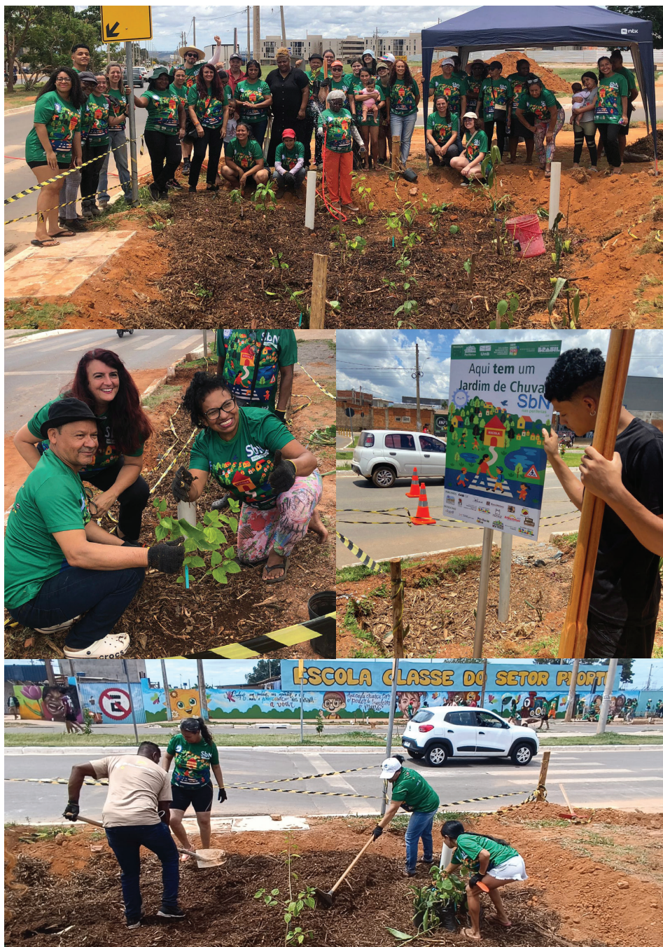
Figura 168: Registros da construção dos jardins de chuva na região da ECPN
