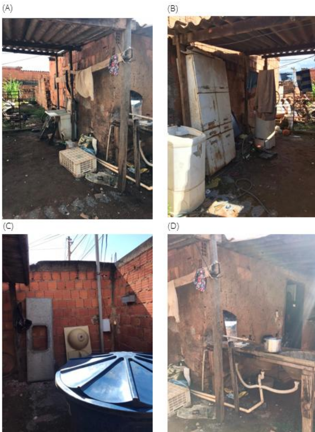
Figura 28: Registros fotográficos da habitação Maria Clara antes das intervenções – área externa.
