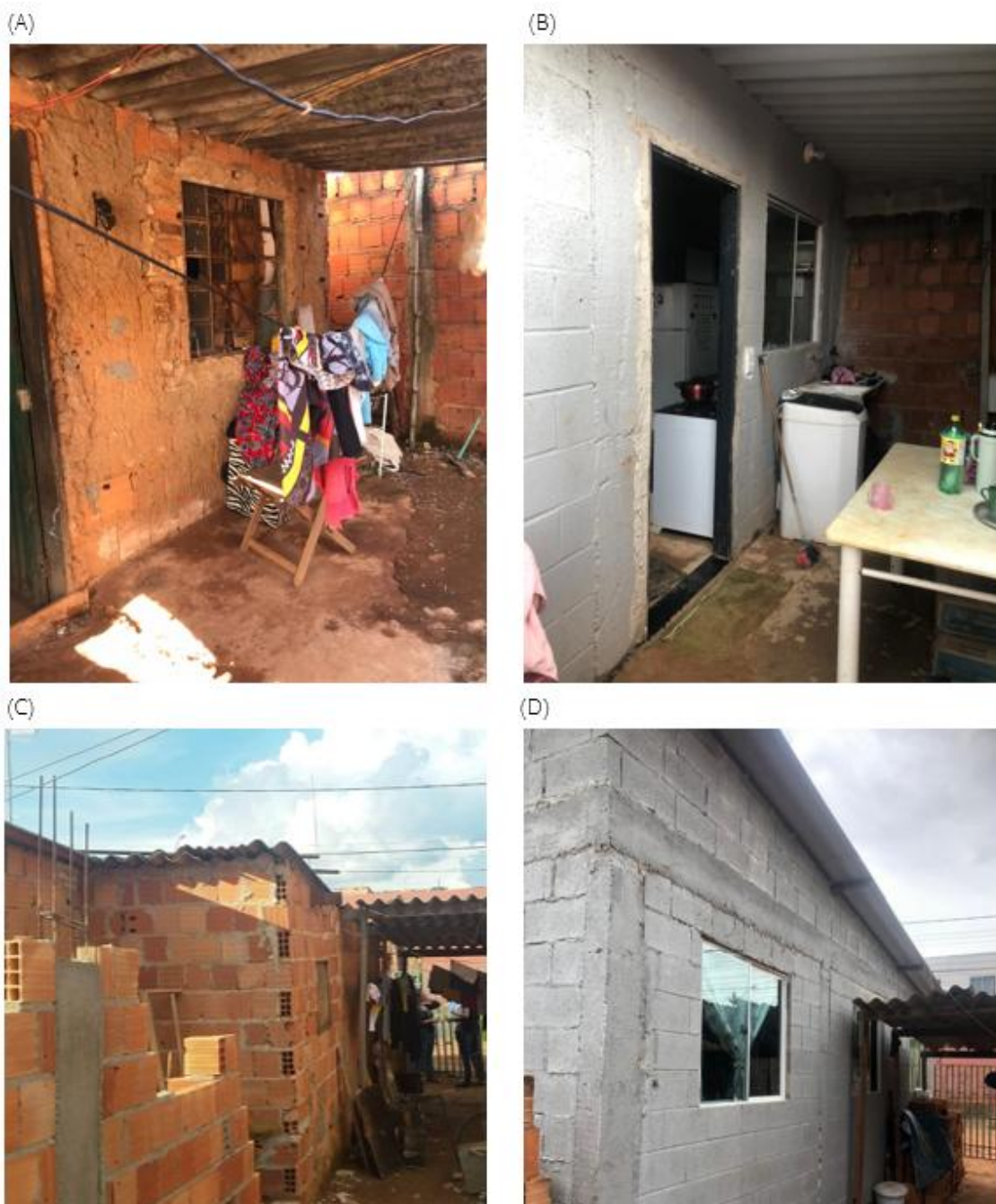
Figura 37: Registros fotográficos da habitação Maria Clara durante as intervenções
