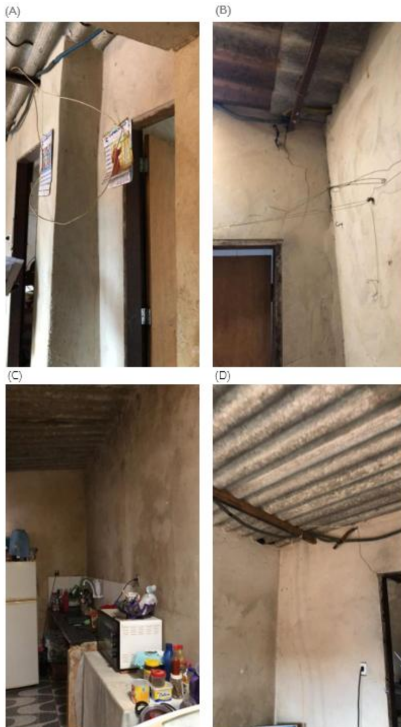
Figura 18: Registros fotográficos da habitação Evandro antes das intervenções – ambiente interno.
