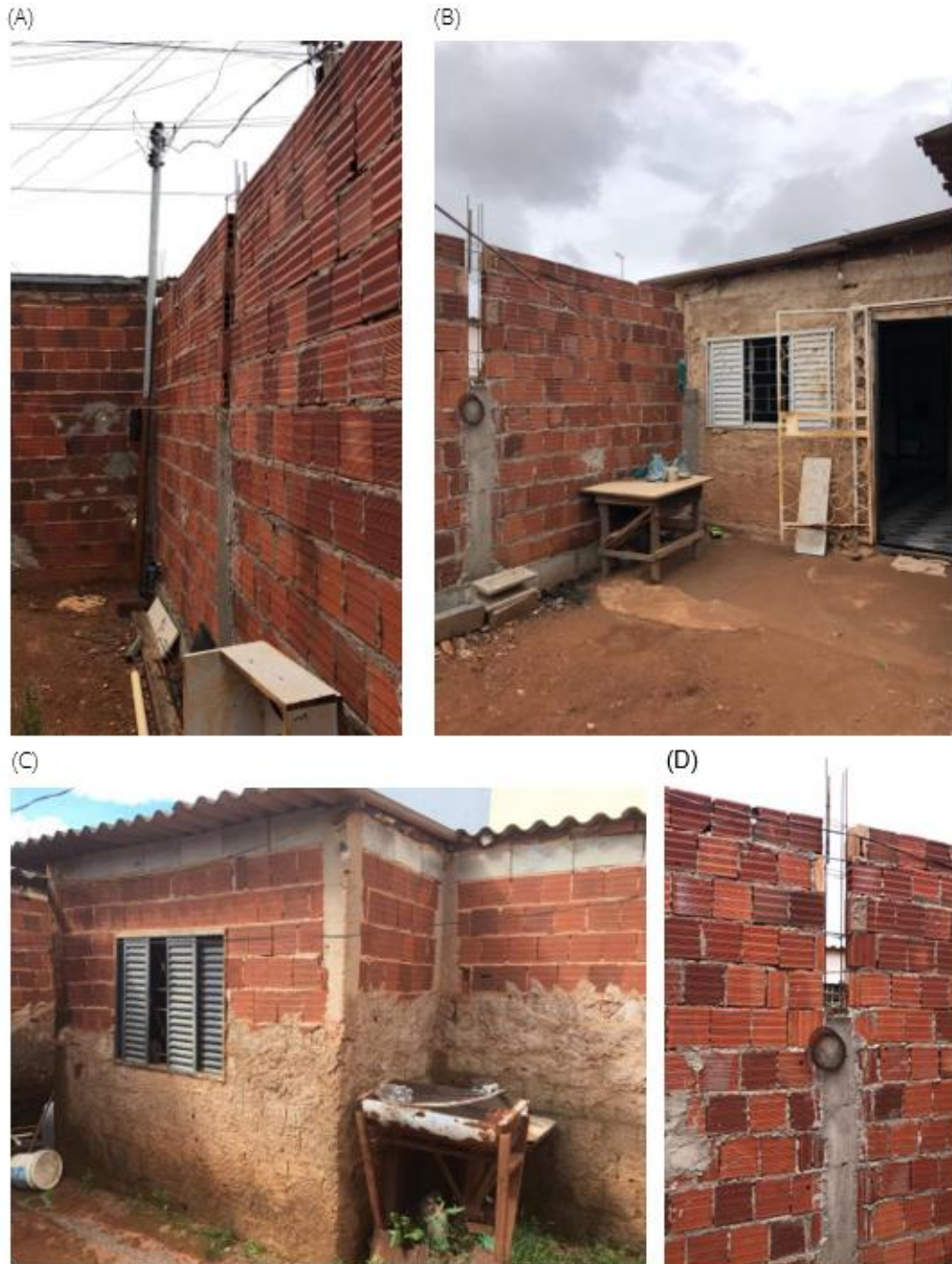
Figura 17: Registros fotográficos da habitação Evandro antes das intervenções – área externa
