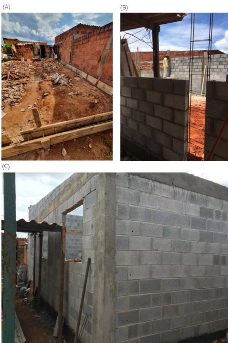
Figura 33: Registros fotográficos da habitação Maria Clara após as intervenções.
