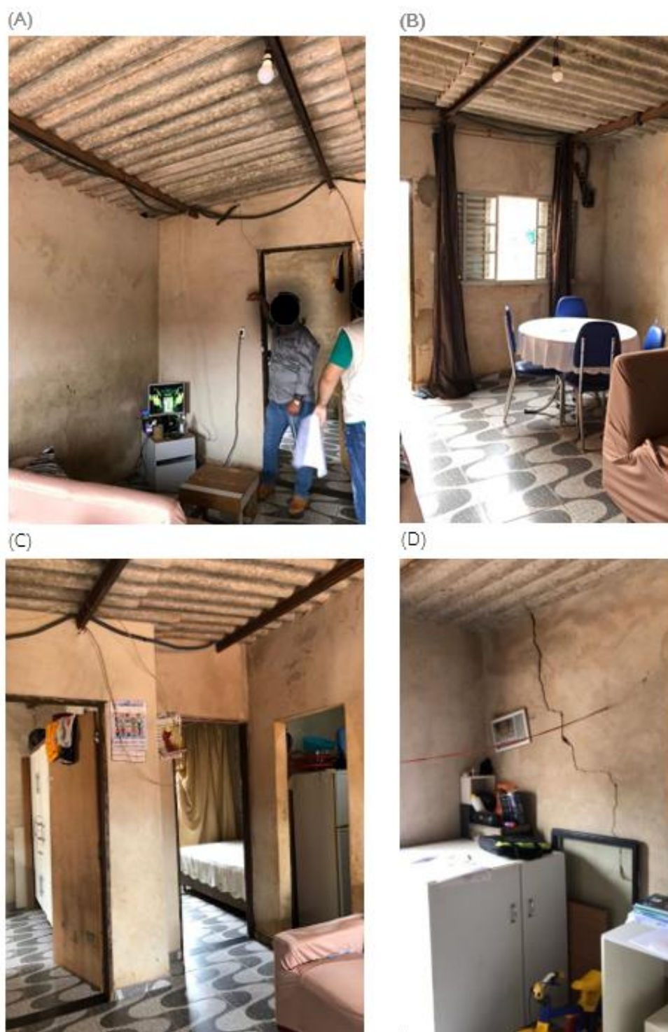
Figura 19: Registros fotográficos da habitação Evandro antes das intervenções – ambiente interno.
