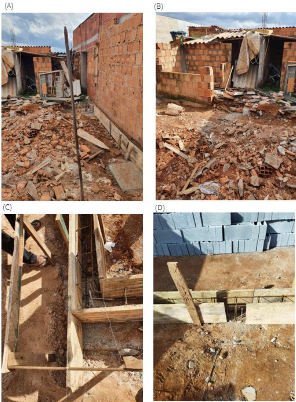
Figura 31: Registros fotográficos da habitação Maria Clara durante as intervenções.
