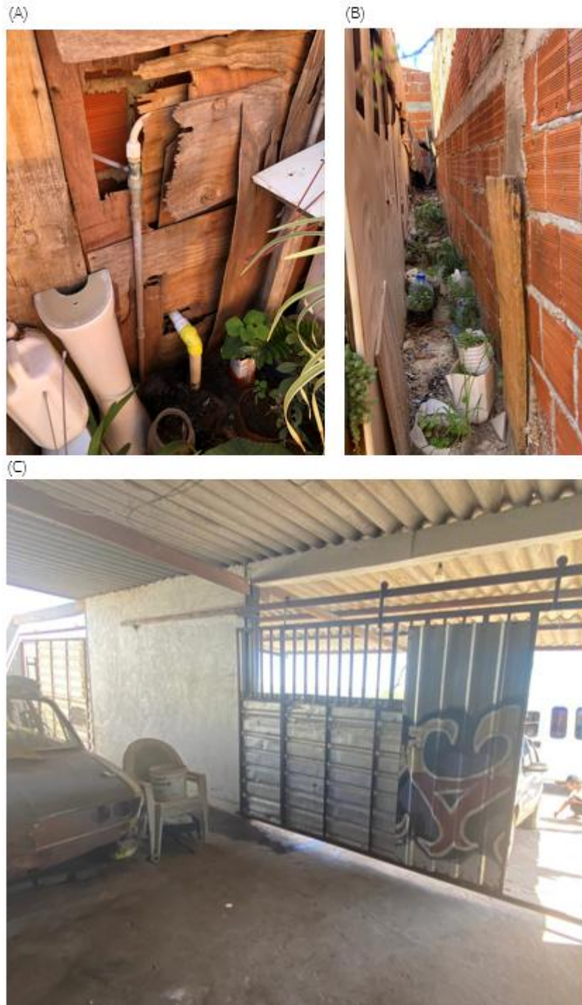
Figura 58: Registros fotográficos da habitação Ana Maria antes das intervenções – área externa.
