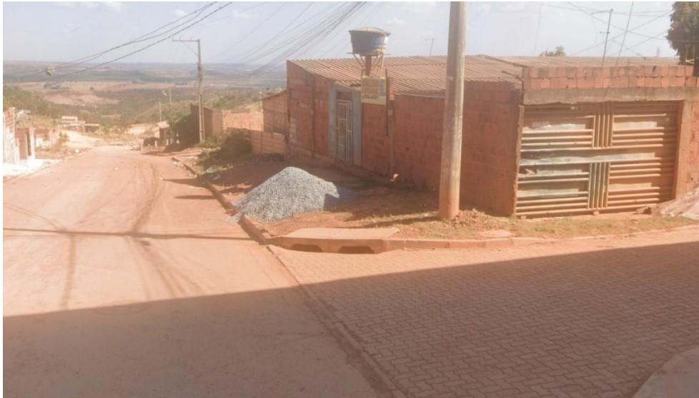
Figura 24: Pavimentação asfáltica em vias locais e coletoras do Trecho 03 do Setor Habitacional Sol
