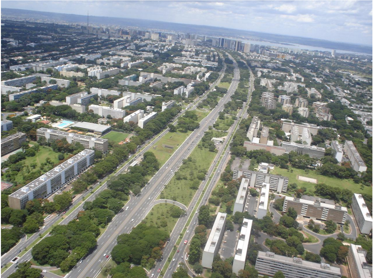
4 Figura 6: Canteiros ladeando as margens leste e oeste ao longo do Eixo Rodoviário de Brasília. Fonte: autores.
