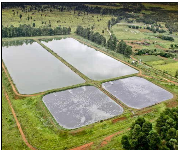
Figura 9- Vista do sistema de lagoas da ETE-Brazlândia, com lagoas anaeróbias na porção inferior
