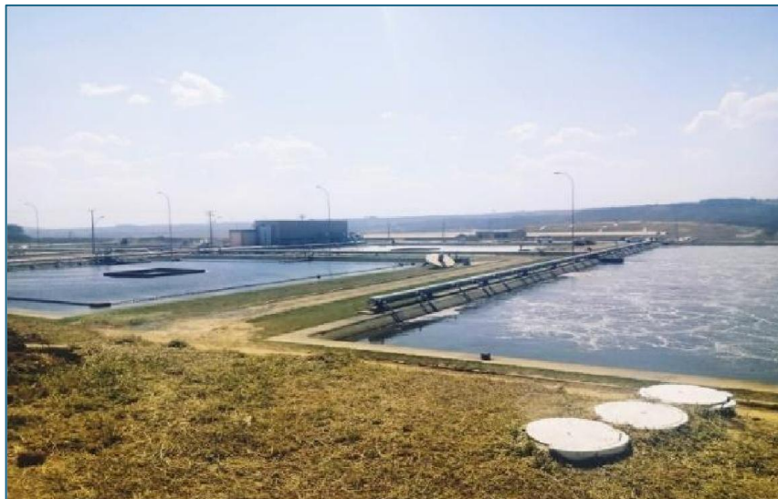
Figura 3- Reatores Aerados Difusos da ETE-Melchior, fase de aeração (à direita) e decantação (à esquerda).
