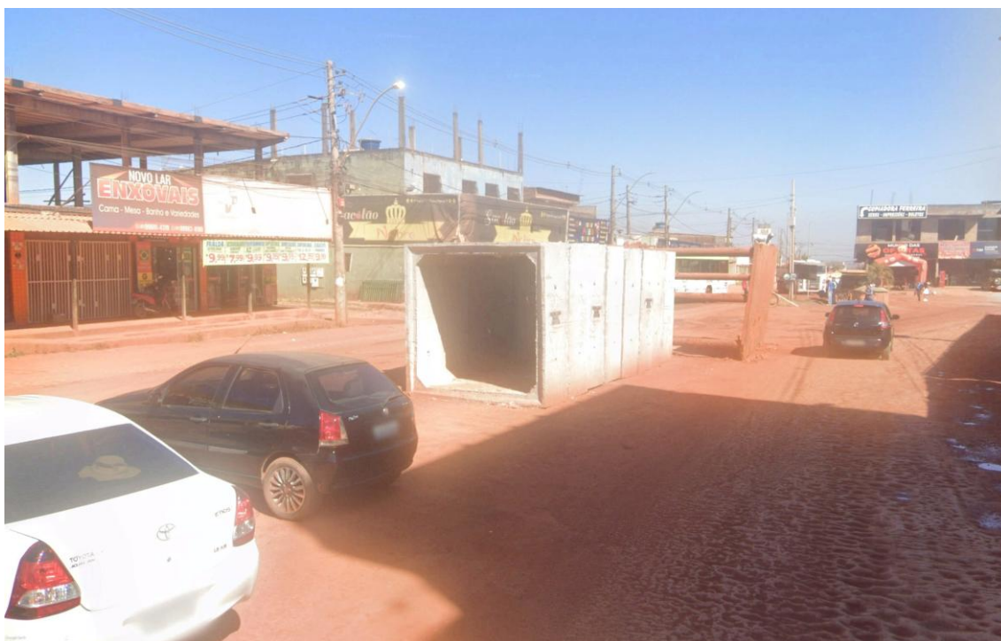
Figura 52 – Galerias implantadas no Trecho 3.
