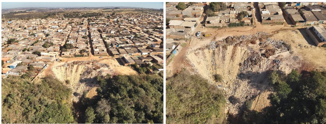
Figura 46 - Rebordo erosivo no Trecho 3 do SHSN.
