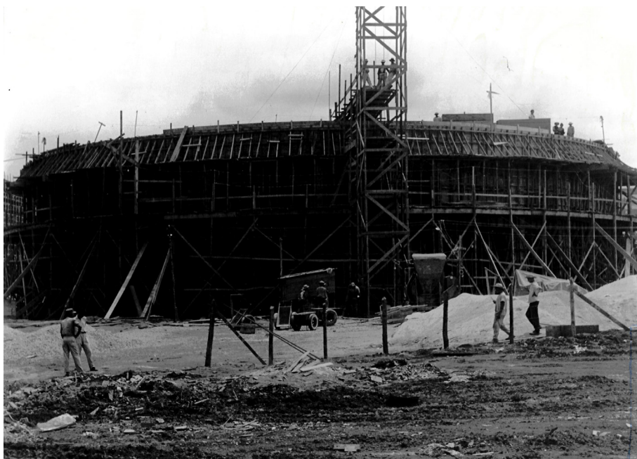
Figura 7 – Cine Brasília em construção. Fonte: ArPDE, 1960.
