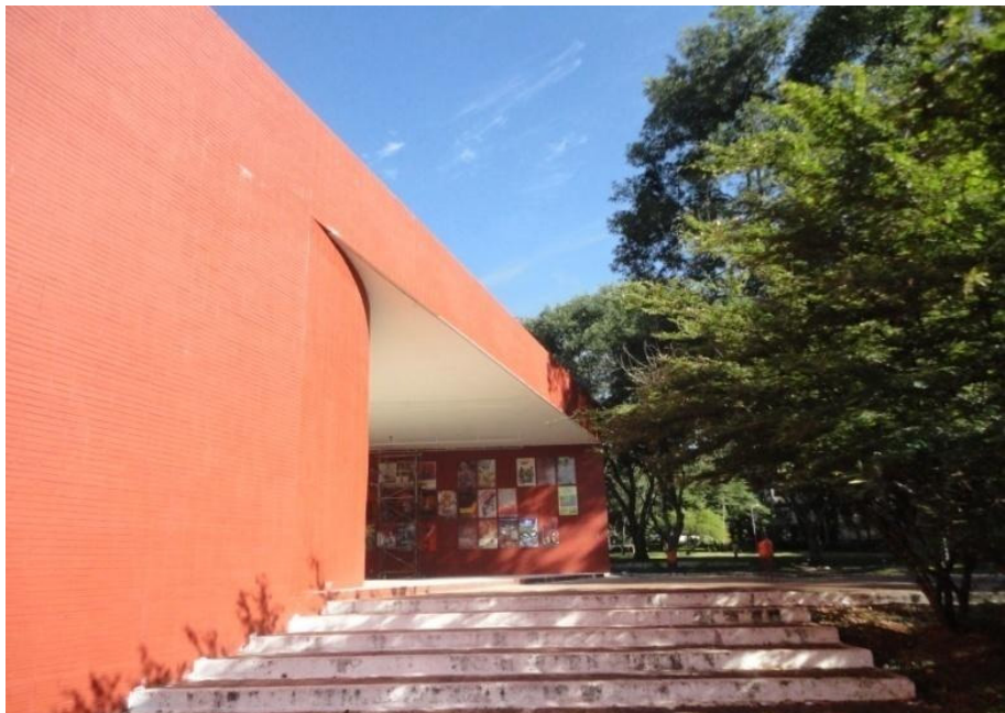
Figura 26 – Fachada nordeste fotografada para a disciplina de Técnicas Retrospectivas (FAU/UnB). Fonte: Aline Mendes, 2011.
