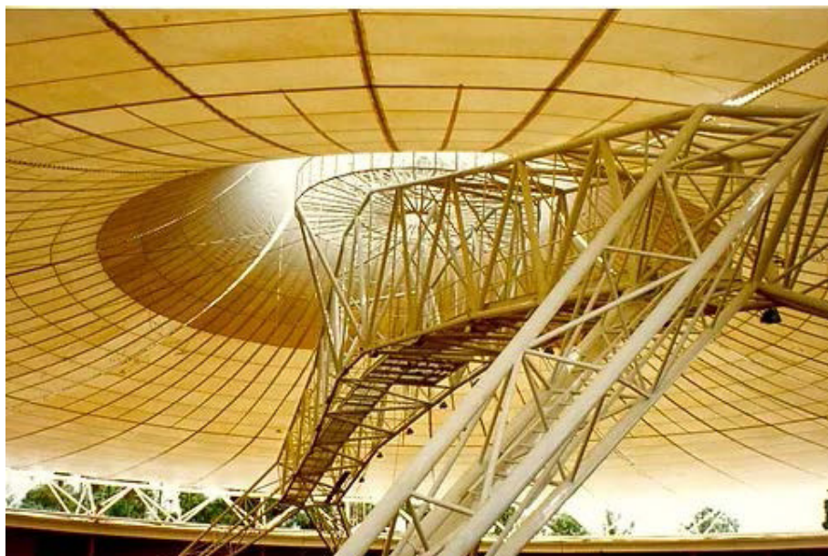
Figura 54 – Cobertura em lona tracionada vista a partir do interior do Auditório Araújo Vianna. Fonte: Acervo prof. Sérgio Marques, 1996.
