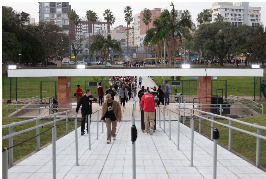
Figura 69 – Marquise que demarca o acesso principal do Auditório Araújo Vianna. Ao fundo, a Avenida Osvaldo Aranha. Fonte: Marina Lira, 2024.
