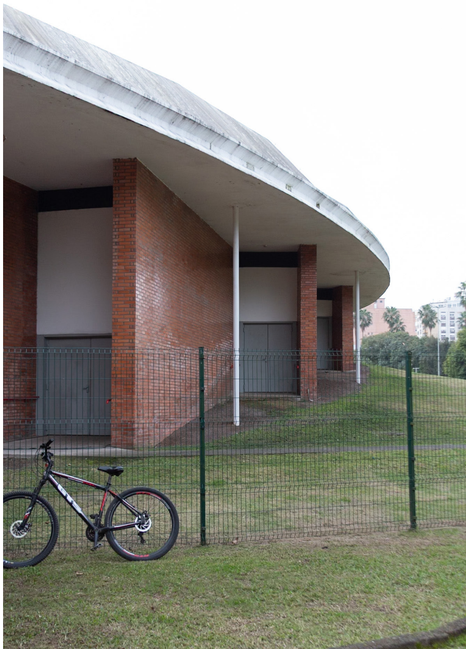
Figura 66 – Fachada lateral do Auditório Araújo Vianna, com as paredes em planos soltos, originais do projeto de 1964, agora fechadas por questões acústicas. Fonte: Marina Lira, 2024.
