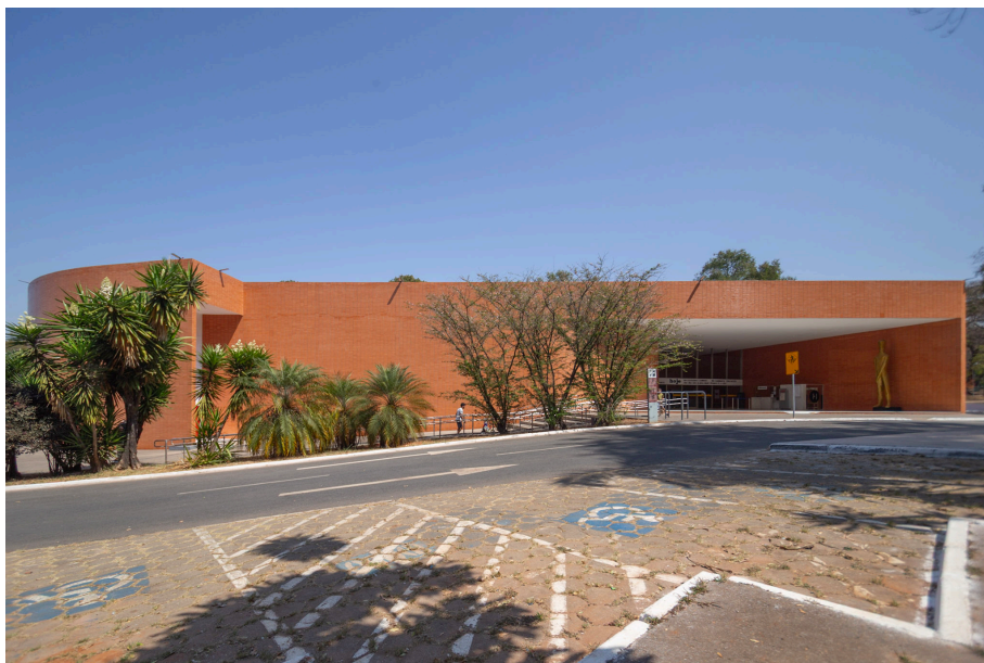
Figura 30 – Fachada nordeste do Cine Brasília. Fonte: Marina Lira, 2024.
