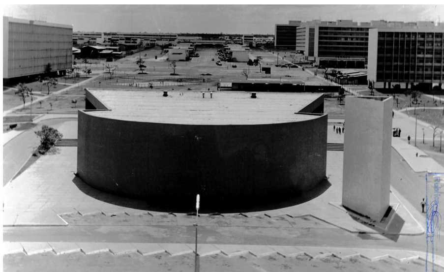
Figura 3 – Fachada sudeste do Cine Brasília, com torre de refrigeração à direita. Fonte: ArPDF, 1960.
