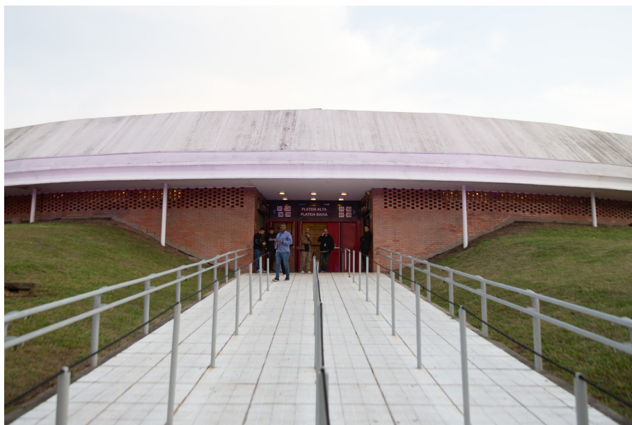
Figura 70 – Entrada do Auditório, com corrimão acessível instalado nas laterais e, ao centro, montantes para separação de filas. Fonte: Marina Lira, 2024.
