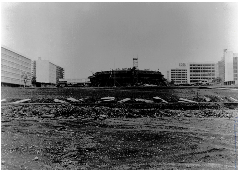
Figura 8 – Cine Brasília em construção. Fonte: ArPDE, 1960.
