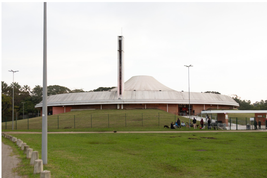
Figura 67 – Auditório Araújo Vianna. Na foto, observa-se a relação entre a topografia, as paredes originais – revestidas em tijoletas –, a nova cobertura definitiva e a torre de iluminação. Fonte: Marina Lira, 2024.
