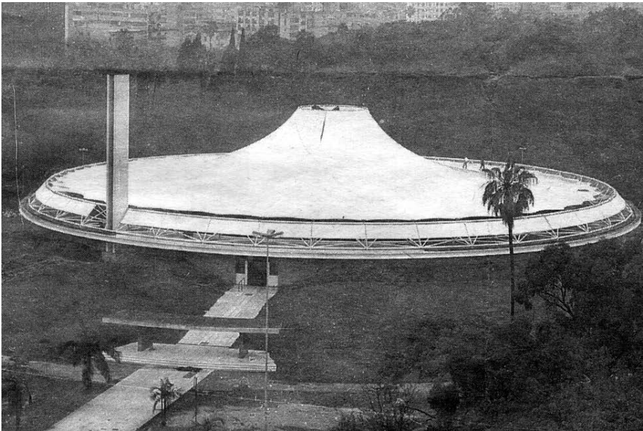
Figura 53 – Auditório Araújo Vianna com a cobertura em lona tracionada. Fonte: Acervo prof. Sérgio Marques, 1996.
