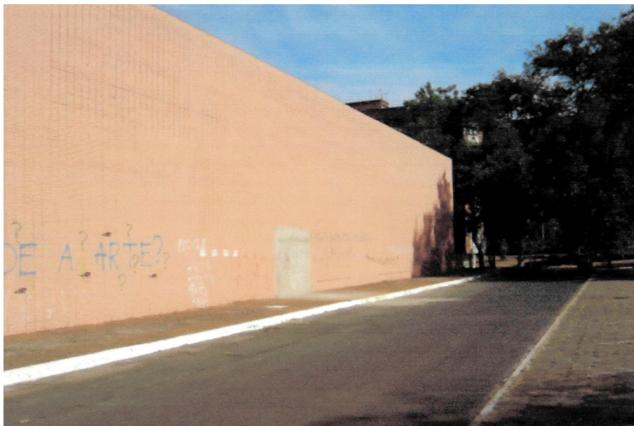
Figura 21 – Fachada Noroeste (com marcação de fechamento da porta “provisória” que integrava o foyer com o estacionamento posterior) fotografada para laudo técnico de tombamento. Fonte: SUPAC GDF, 2006.
