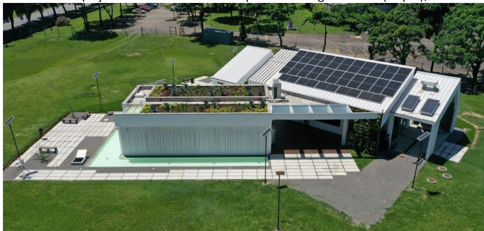
Figura 2.5: Edifício Espaço nZEB do Centro de Pesquisa de Energia Elétrica (Cepel), no Rio de Janeiro.
