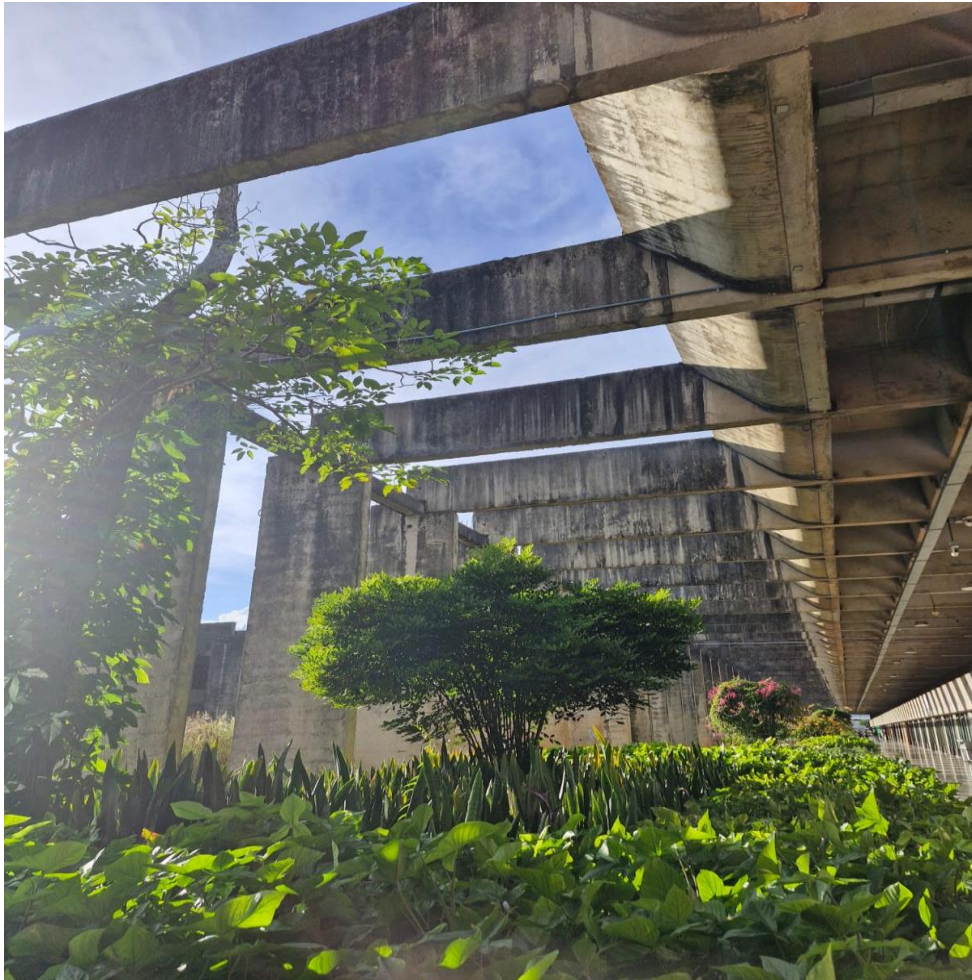
Figura 3 - Corredor externo da FAU/UnB
