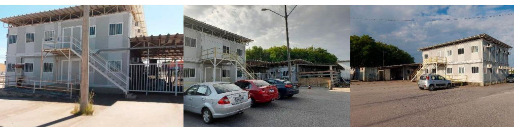
Figura 12. ‘Módulos habitacionais’ das Engenharias instalados no estacionamento, atual sede do Instituto Politécnico da UFRJ.
