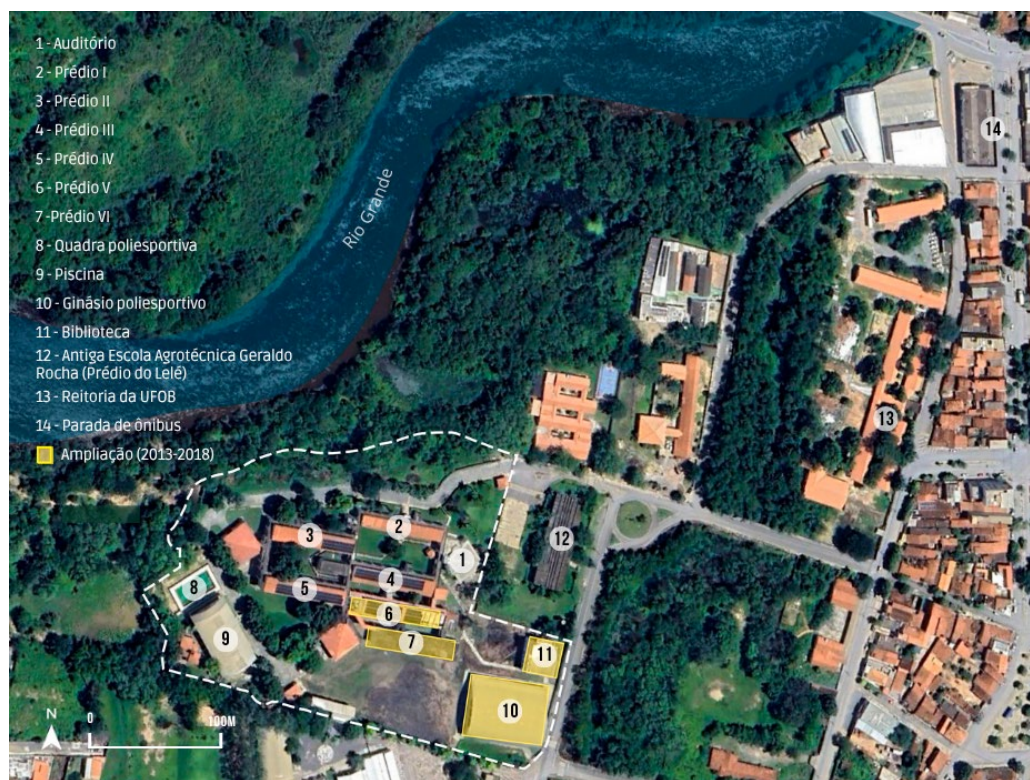
Figura 2. Implantação do IFBA-Campus Barreiras com destaque para os edifícios construídos a partir de 2013, o Prédio do Lelé e o ponto de ônibus mais próximo.
