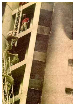
Figura 22 – A faixa vertical dos banheiros possibilitou muitos salvamentos.
