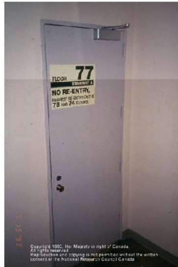
Figura 10 – Foto da porta da saída de emergência da Torre Norte.
