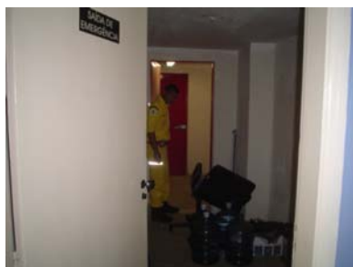
Foto 8 – A escada servindo de depósito
