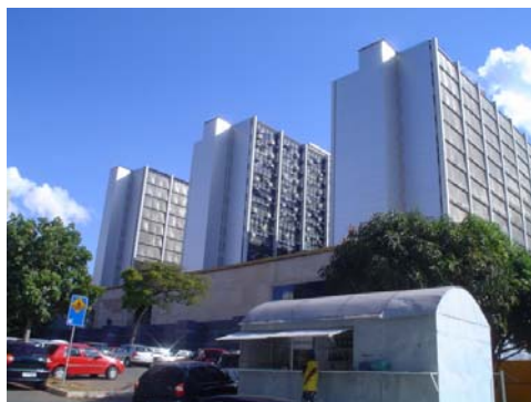
Foto 15 – Vista das três torres mostrando o volume das escadas de emergência.
