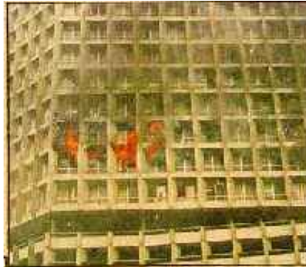
Figura 17 - Início da propagação horizontal do incêndio no Edifício Joelma.
