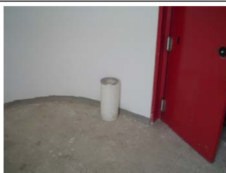
Foto 36 – Cinzeiros dentro das escadas.
