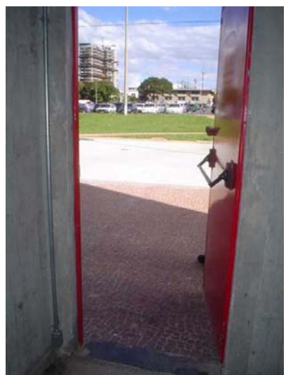
Foto 9 – A via pública vista de dentro da escada de emergência (descarga)
