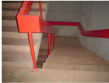
Foto 6 – A escada de emergência
