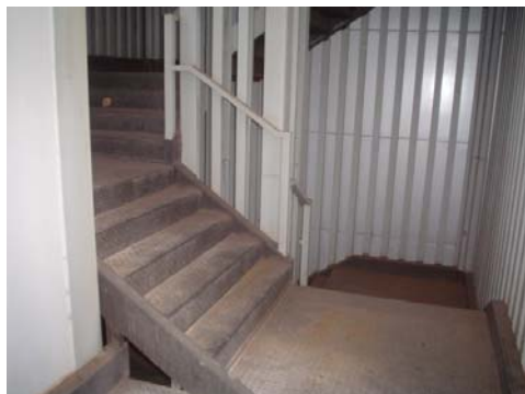
Foto 13 – Escada de emergência metálica.
