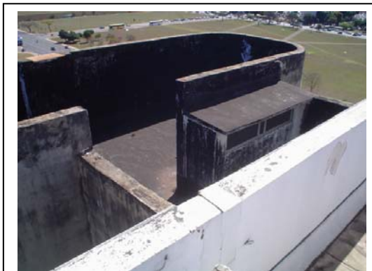
Foto 38 – Vista da cobertura da saída do duto de ar.
