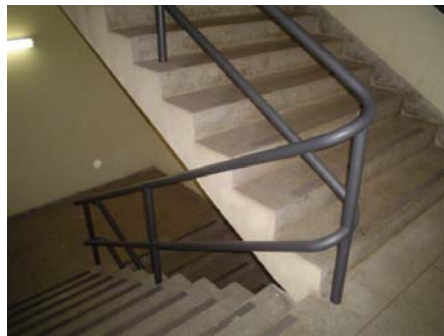
Foto 35 – Escada de emergência
