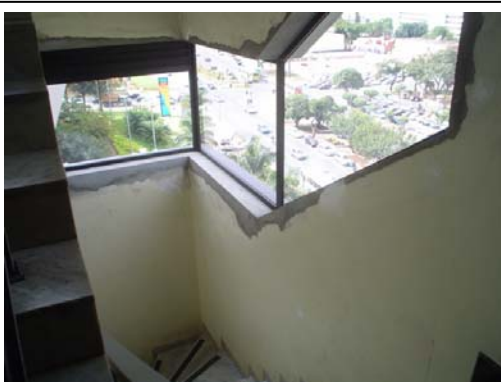
Foto 24 – Instalação de esquadrias em vidro e veneziana.
