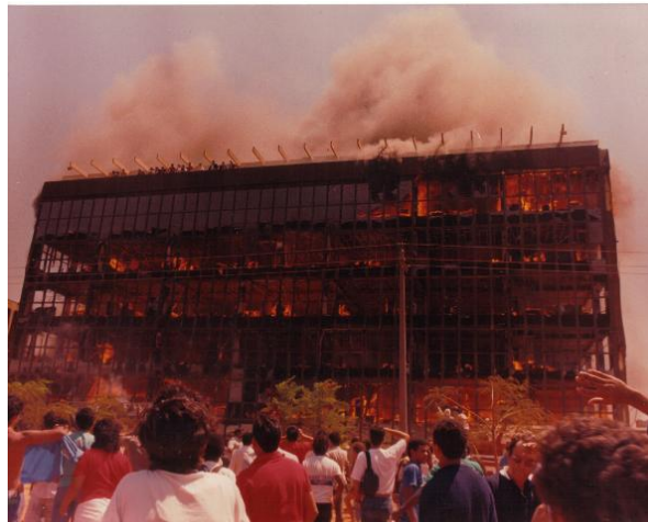
Figura 24 – O edifício em chamas.
