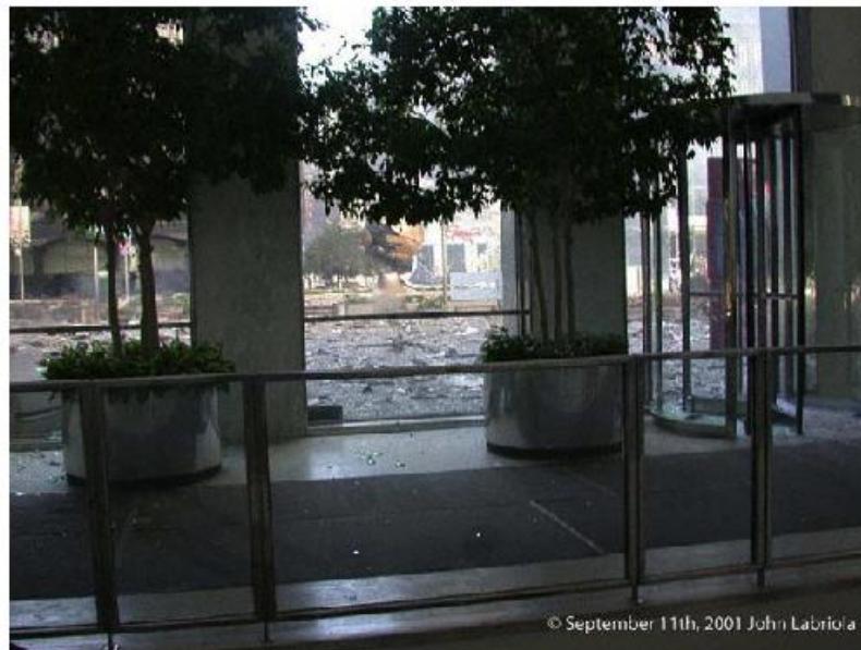
Figura 11 – Foto tirada no nível da rua por dentro do WTC 1, onde se vê os escombros que cobriram a praça central.
