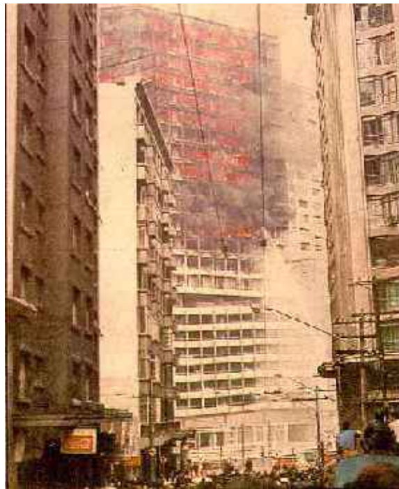
Figura 18 – O incêndio tomou conta de toda a área de escritórios.
