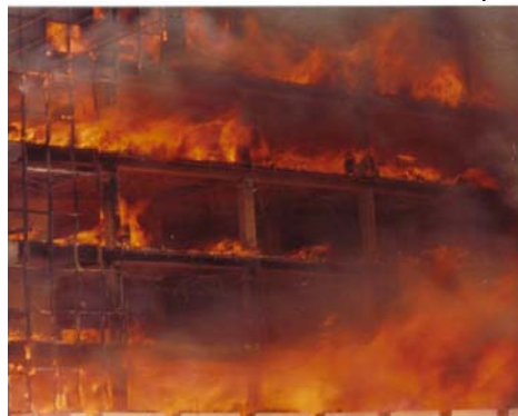
Figura 25 – Painéis de vidros estourados pelo fogo.
