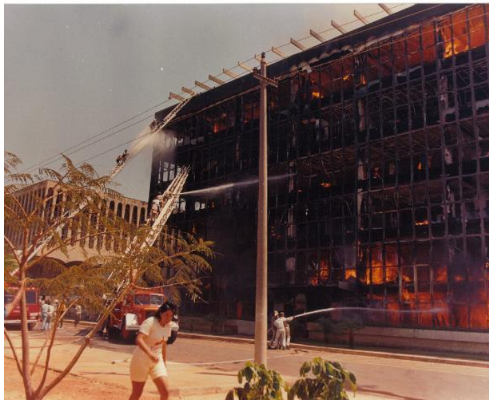
Figura 28 – O final do incêndio, o que restou do edifício.
