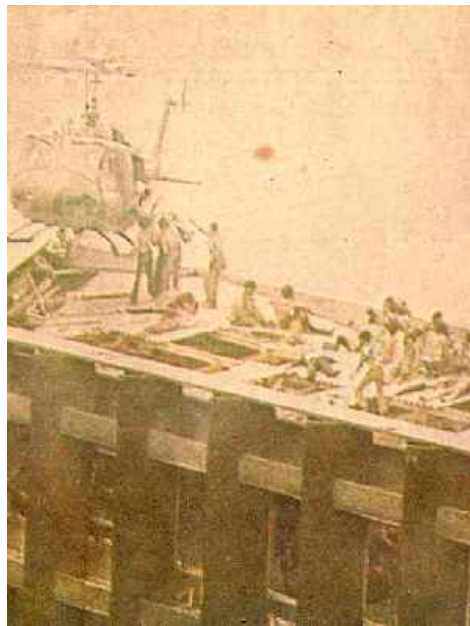
Figura 20 – O resgate de pessoas que se alojaram sobre a telha de cimento amianto após a extinção do incêndio.
