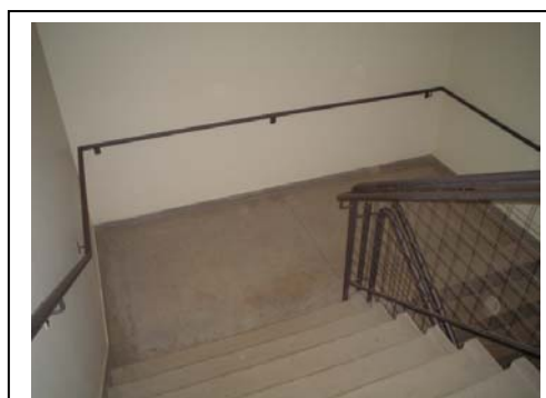
Foto 21 – Escada de emergência (correta instalação de corrimãos)
