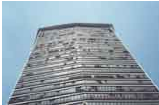
Figura 14 – Edifício Andraus após reforma (fachada frontal).
