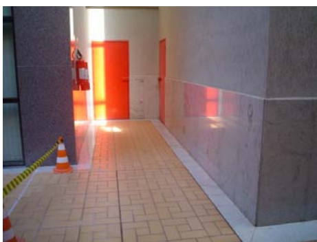
Foto 22 – Descarga em área de pilotis
