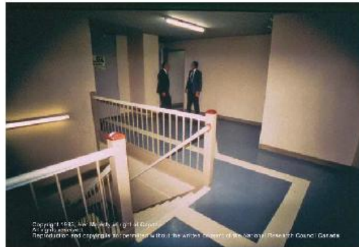
Figura 6 – Transferência horizontal das escadas de emergência.
