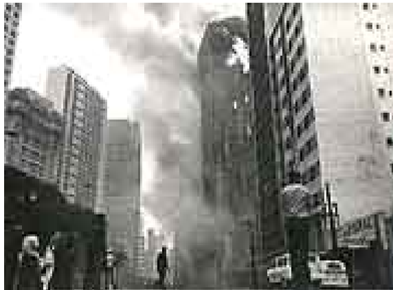
Figura 12 – Incêndio no edifício Andraus.
