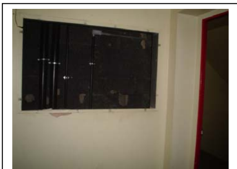
Foto 16 – Vista do duto de ventilação da antecâmara da escada.
