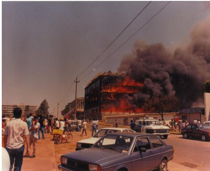
Figura 26 – A cortina de fumaça e fogo presente no edifício.
