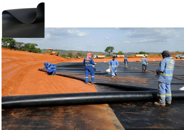
Figura 2.3 - Aplicação da geomembrana em aterro sanitário
