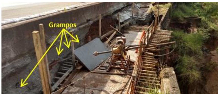
Figura 3.10 - Execução de solo grampeado na cicatriz da ruptura.
