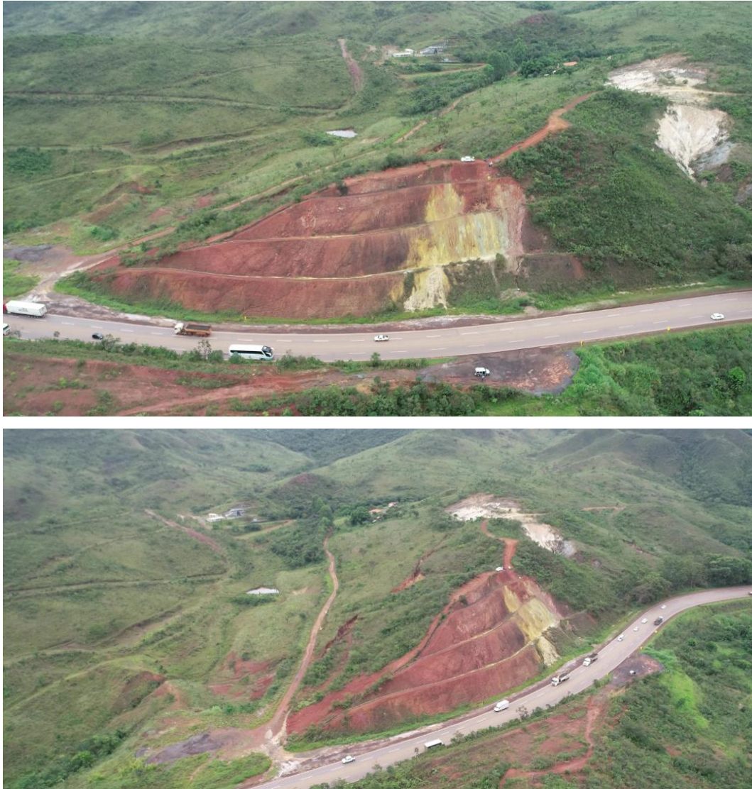
Figura 6.12 – Vista aérea do MA03, com registro dos processos erosivos mobilizando em solos com as colorações que foram ensaiados.
