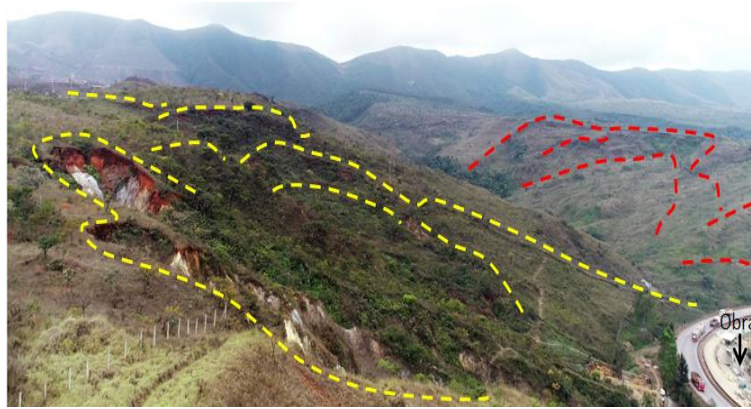
Figura 3.8 - Bacia de contribuição com feições de movimentação de massa, destacando áreas de voçoroca (limites em amarelo) e processos de rastejo (limites em vermelho), além da ocorrência de trincas (Fonte: Silva; Costa; Ehrlich, 2020).
