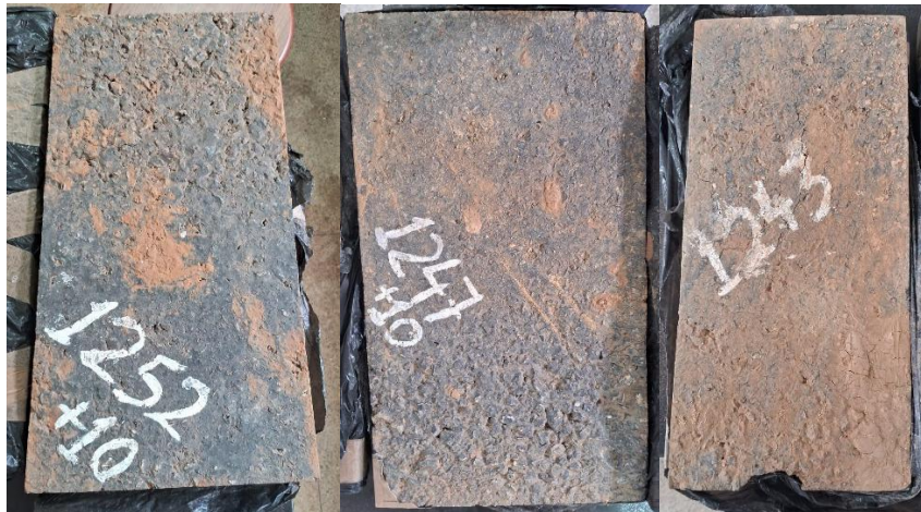
Figura 3.4. Placas de Concreto Asfáltico (CA) extraídas do revestimento dos SE. (Fonte: Autor)
