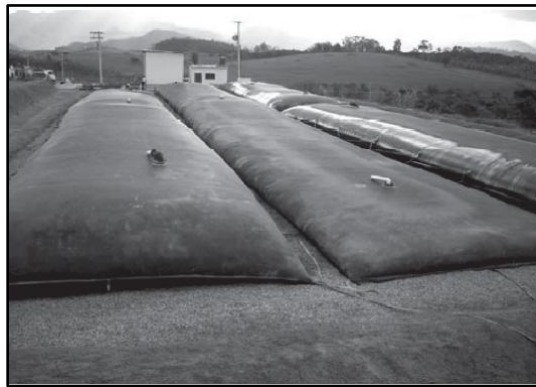
Figura 2.4 - Tubos geotêxteis para desaguamento de efluente em Rio das Ostras (modificado – Castro, 2008)
