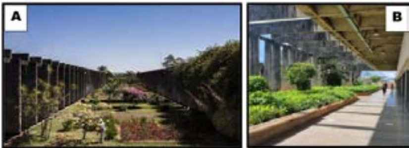
Figura 1. A) Aspecto do jardim entre duas alas do Minhocão onde aparecem colunas ao longo de oitocentos metros. B) Sob as colunas ficam corredores ao lado de salas de aulas, anfiteatros e laboratórios de professores. O prédio evoca a convivência persistente de docentes e discentes. (Fotos: Julia Lozzi.)
