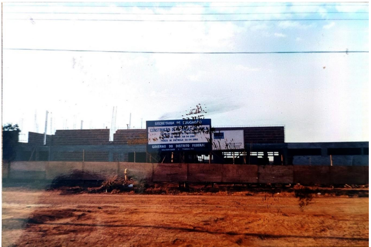
Construção do CEF 802 do Recanto das Emas, 2001. Acervo do CEF 801 do Recanto das Emas.
