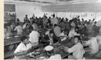
Imagem 32: Candangos no refeitório.
