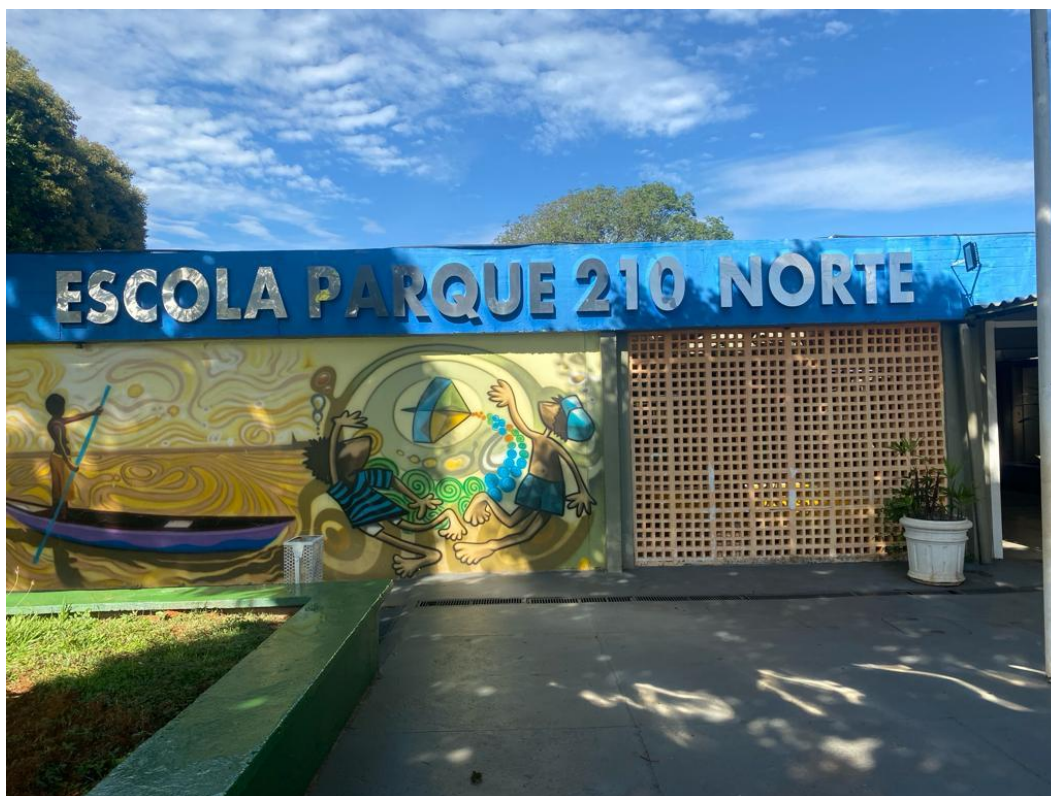
Figura 40 - Entrada da Escola Parque 210/211 Norte
