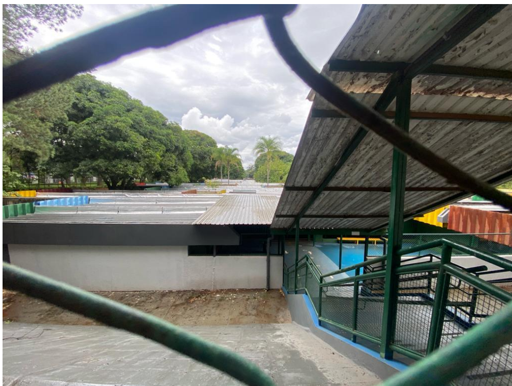
Figura 35 - Detalhe da entrada da Escola Parque 303/304 Norte onde é possível observar as escadas e o telhado na altura da Via W2
