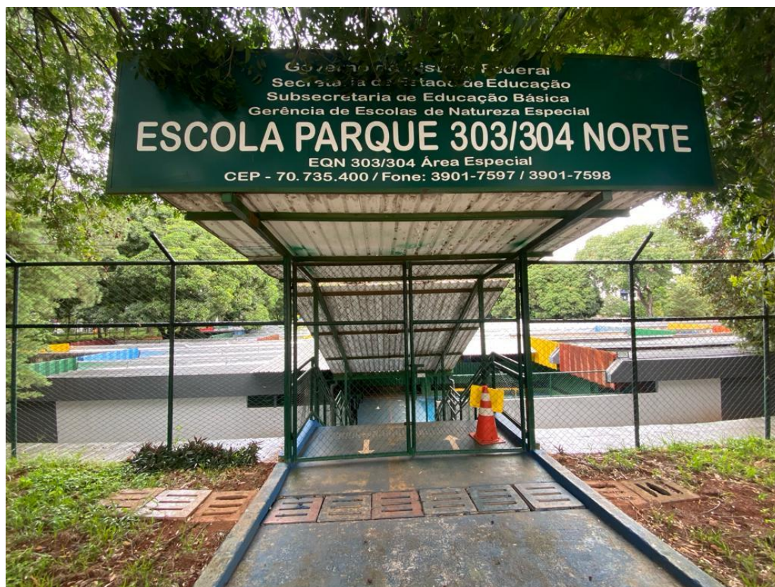
Figura 33 - Entrada da Escola Parque 303/304 Norte
