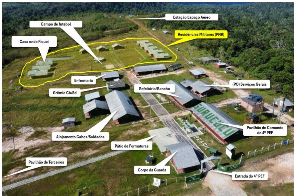
Figura 46 – Vista aérea do PEF de Surucucu
