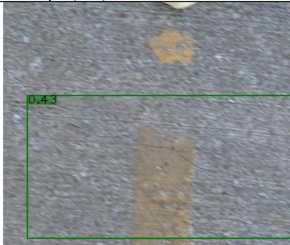
Figura 12 – Detecção de fissuras em ciclovias usando YOLOv8m, YOLO11m, YOLO11l e RT-DETR-l sobre a influência de fatores como desfoque, alta iluminação, sombra e ruído.
