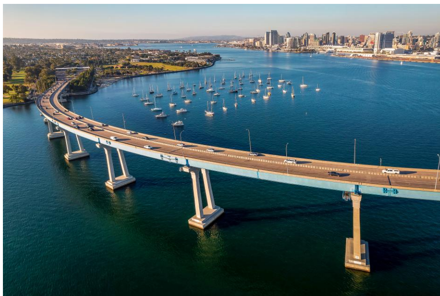
Figura 1 – Coronado Bridge , na Califórnia, EUA.
