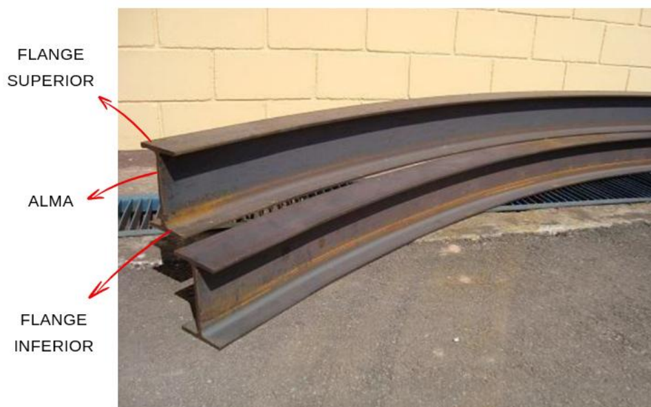
Figura 2 – Seção transversal típica de vigas I de aço com curvatura horizontal. Fonte: adaptada pela autora a partir de < https://www.wanacos.com.br/calandrar-viga-i >.
